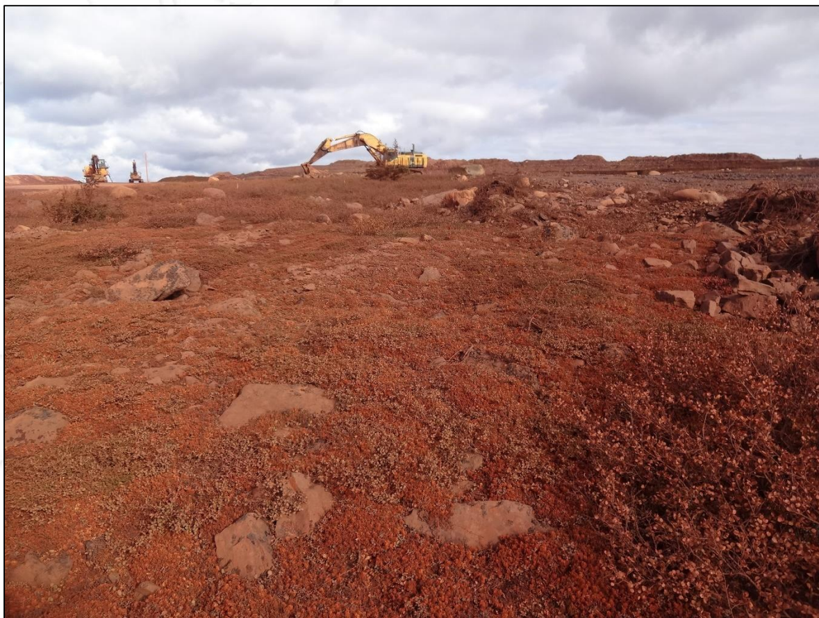
Photo 14 : 1 ère vue de PK30.
