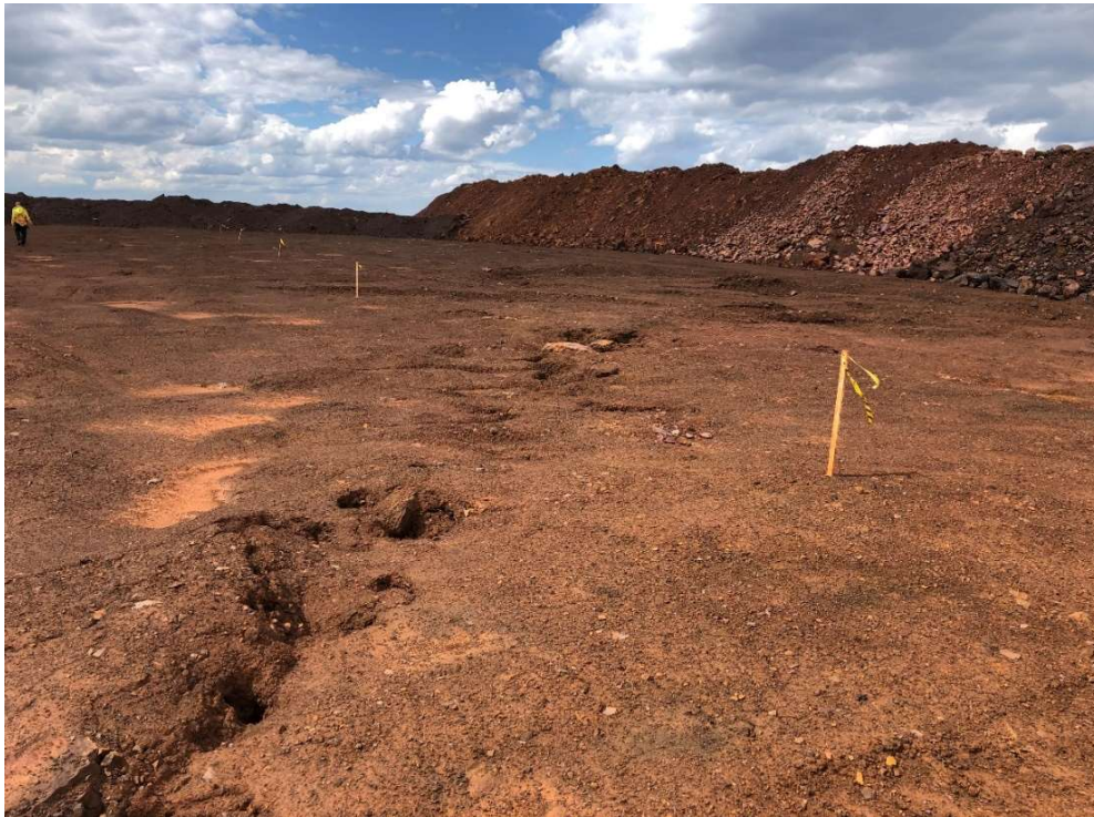
Photo 15 : Halde à stériles, sommet (plateau), fissures et trous d'infiltration des eaux de surface (secteur est)
