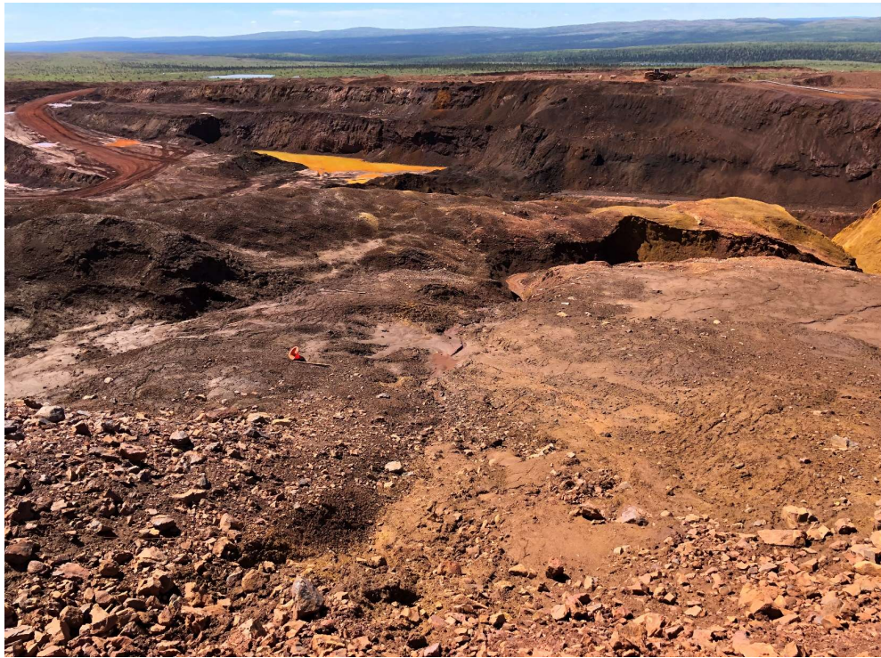
Photo 23 : Fosse à ciel ouvert, écoulement d'eau de surface à plusieurs endroits le long de la paroi nord
