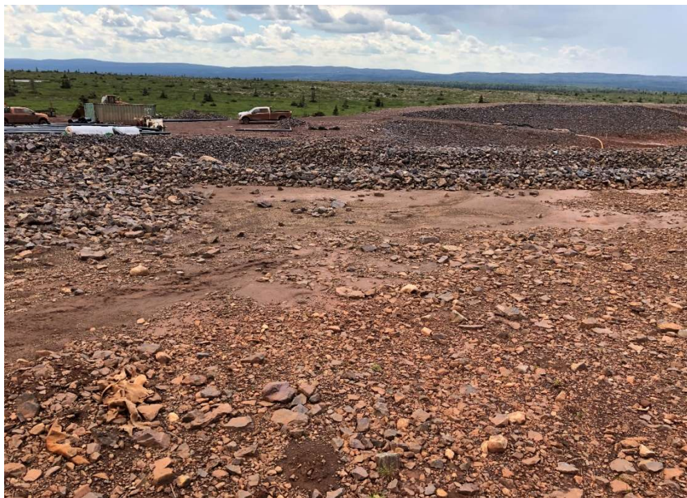
Photo 12 : Halde à stériles, Talus Sud, les décrochements (c.f. photos 11) génèrent des sédiments en amont du fossé et dans le fossé
