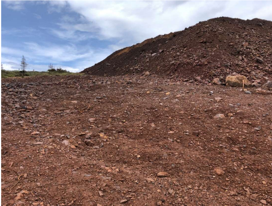
Photo 13 : Halde à stérile, Talus Ouest, des fissures sont présentes sur les merlons de sécurité et des cavités d'infiltration d'eau sont présente, avec signes de tassements
