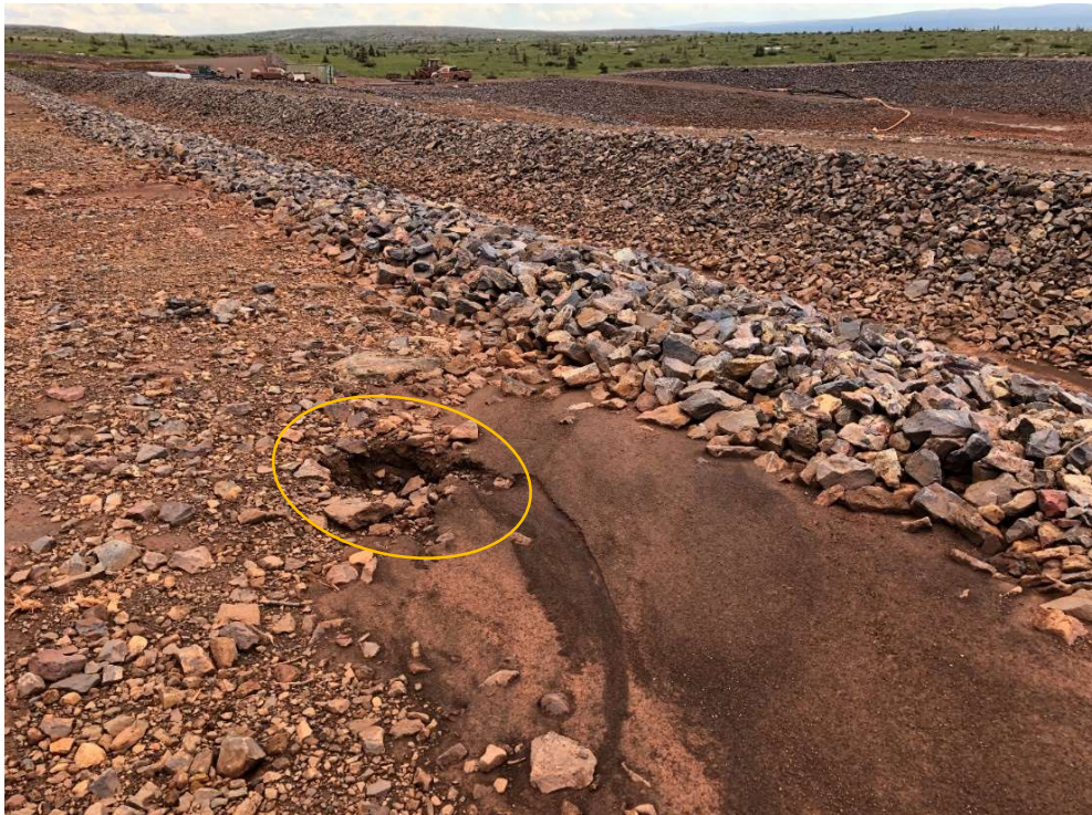
Photo 19 : Fossé entre la halde à stériles et le bassin de sédimentation, un trou d'infiltration d'eau de surface (renard), est visible devant le fossé.
