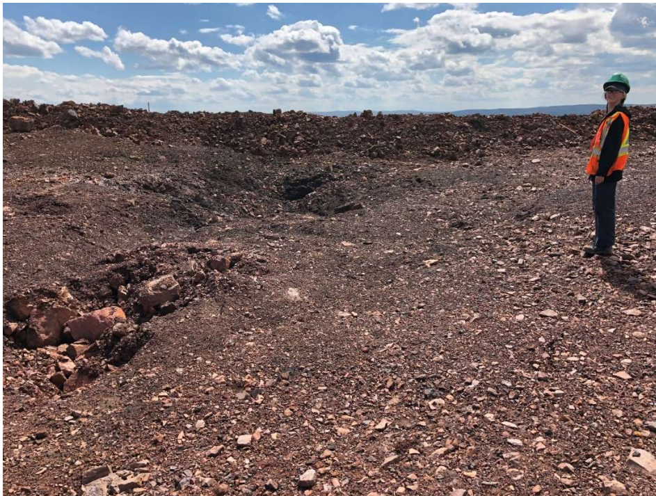
Photo 14 : Halde à stériles, sommet (plateau), renforcements avec trous d'infiltration des eaux de surface
