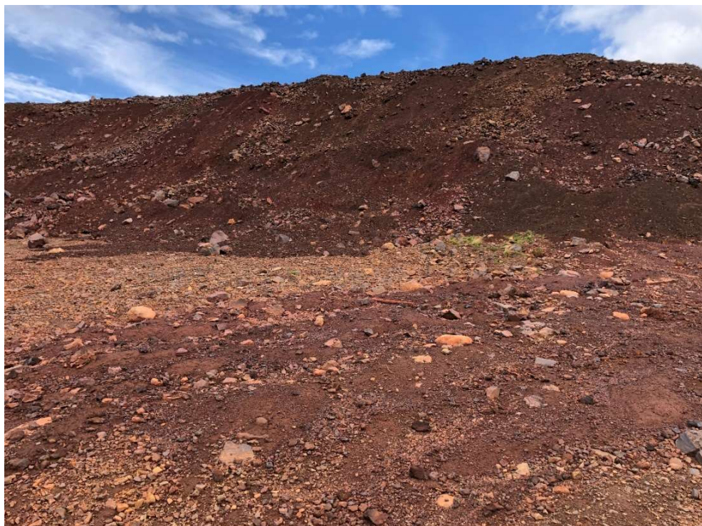
Photo 11 : Halde à stérile, Talus Sud, dans la portion est, plusieurs décrochements de surface sont visibles
