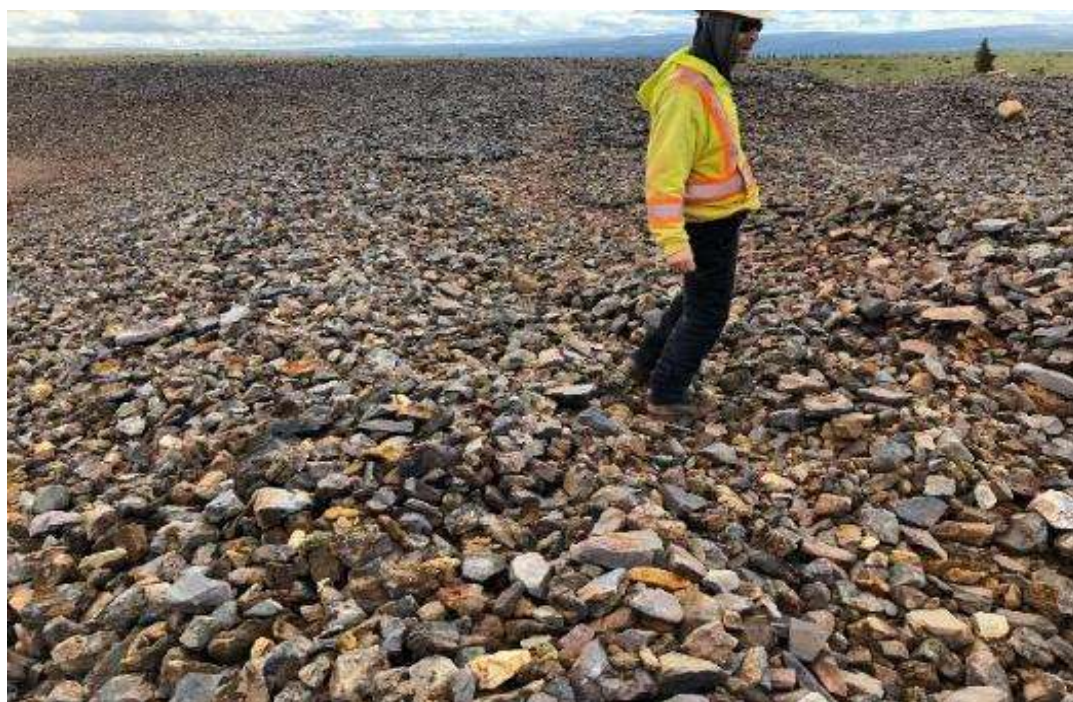
Photo 4 : Digue Sud, une nouvelle dépression est observée sur la partie interne de la crête
