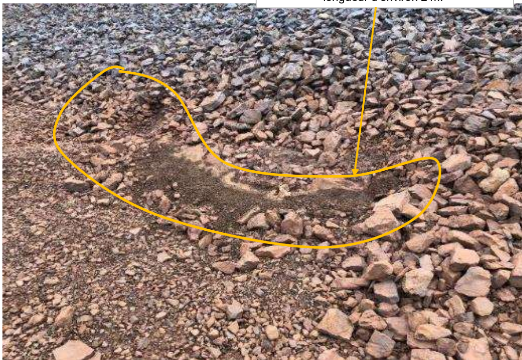
Photos 5 et 6 : Déchirure dans la membrane du talus interne de la digue sud et dépression en haut du talus dans le même secteur
