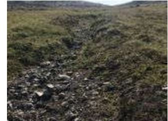
Vue générale - Vers l'aval
