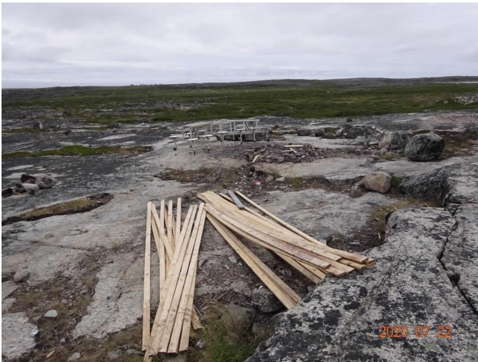
Photo 5-1 : Lieu de rassemblement situé sur le site de la centrale projetée
