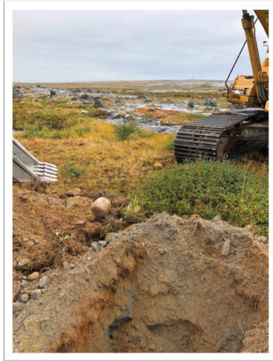
PHOTO 9 — Vue du puits d'exploration PU-20-17 (3 septembre 2020).
