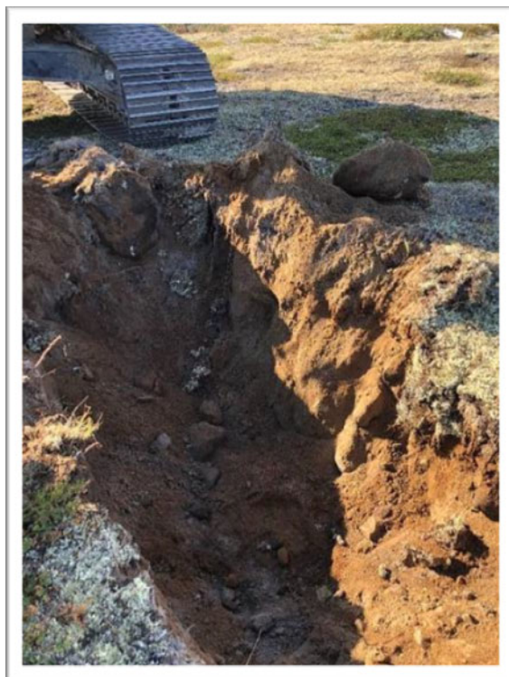
PHOTO 5 — Vue de la réalisation du puits d'exploration PU-20-26 (1 er septembre 2020)
