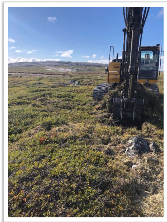
PHOTO 8 — Vue de la portion sud du site à l'étude, vue vers le sud (31 août 2020).
