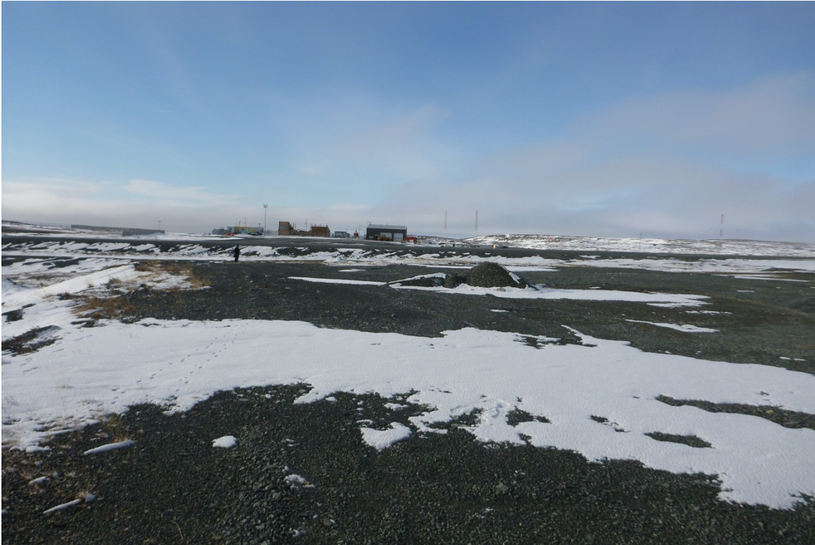
Photo 3 Aire de manœuvre, vue vers la piste d'atterrissage (vers l'ouest).
