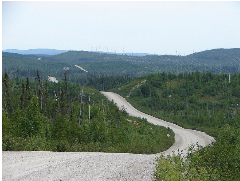
Photo 6-32 : La Route du Nord. Source : routebaiejames.com
