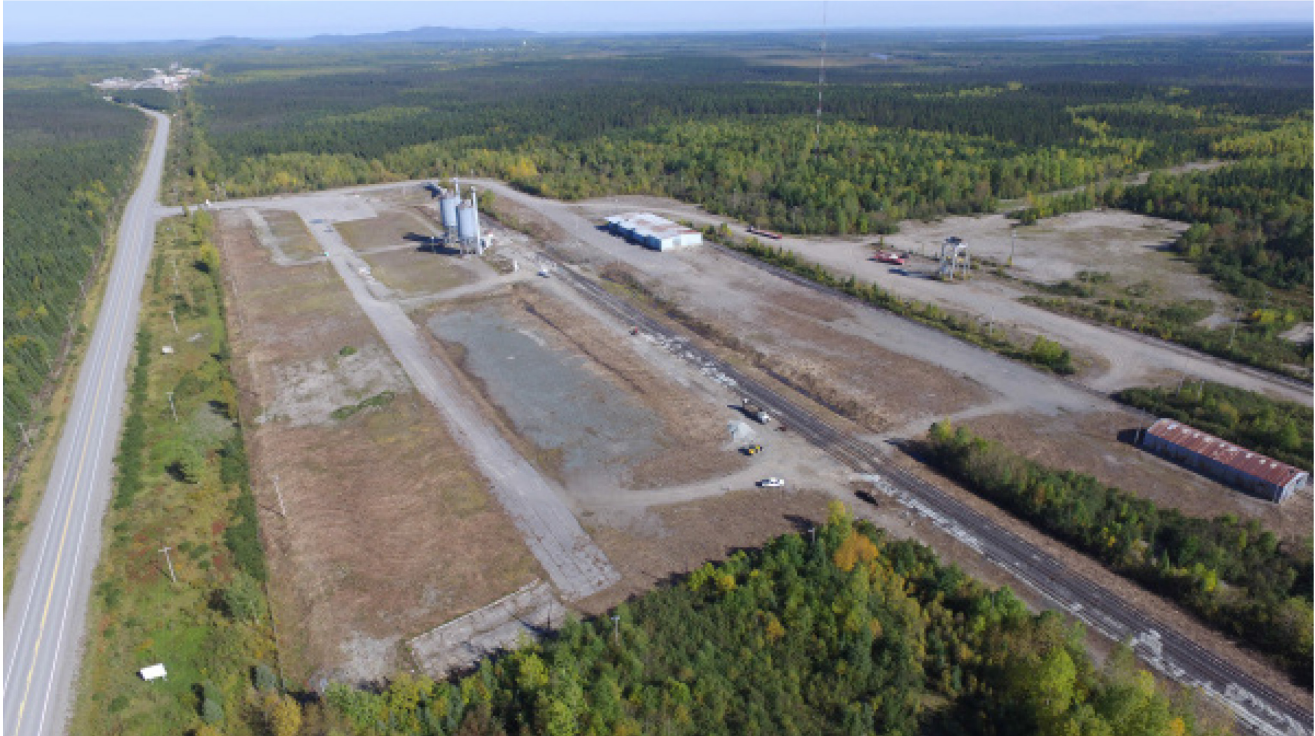
Figure 5-30 : Infrastructures présentes au centre de transbordement de Matagami (CT Matagami, 2019)
