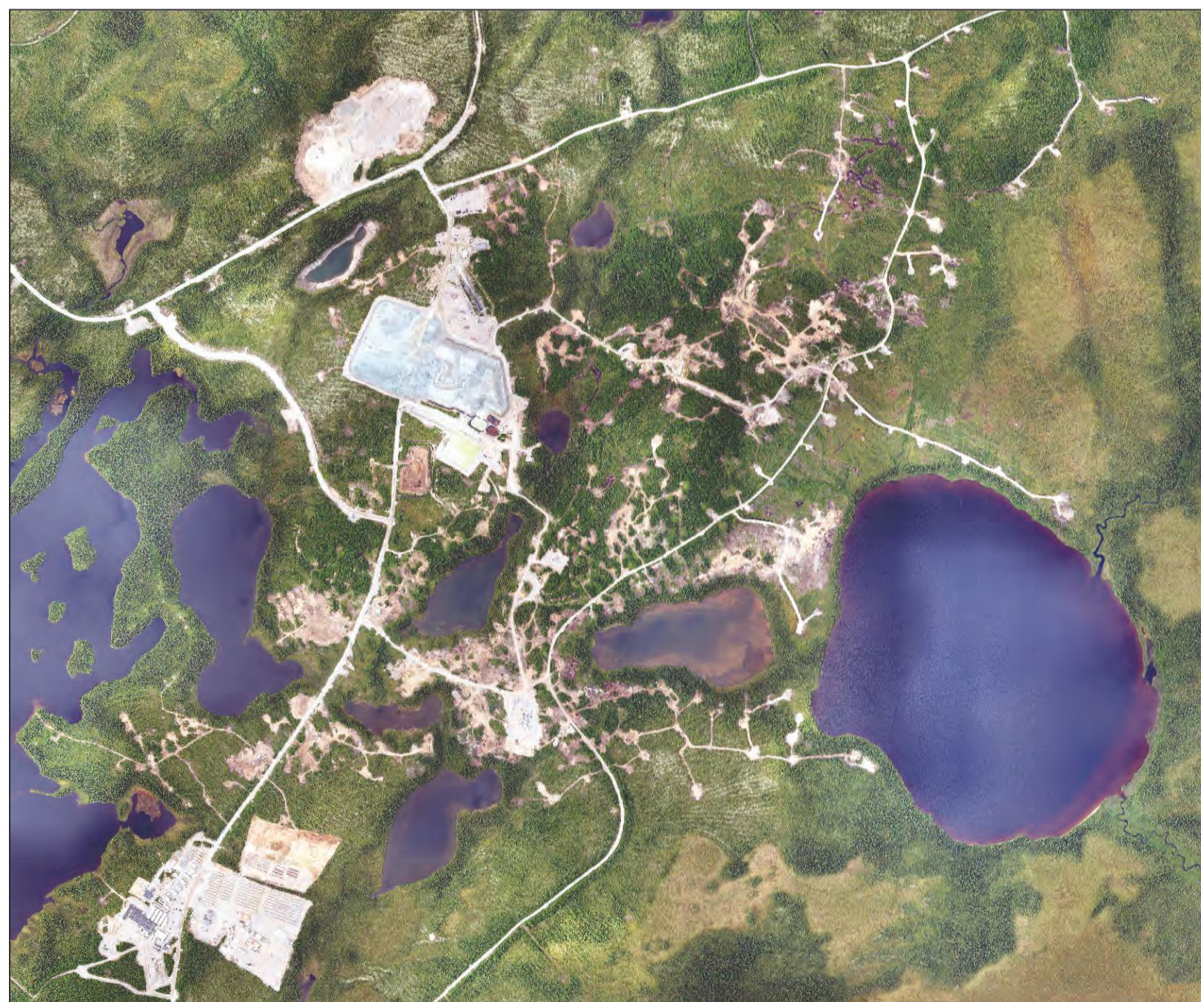
SITE MINIER WINDFALL
