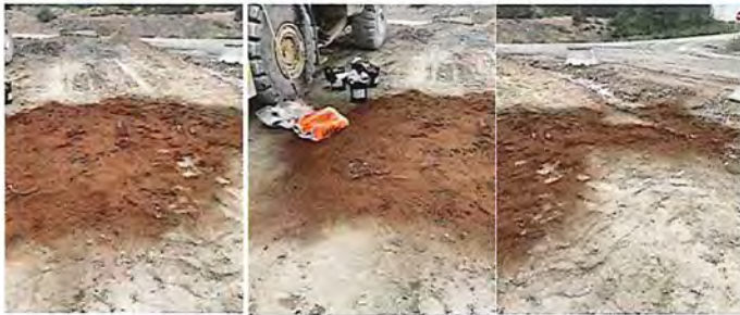
Nettoyage: Excavation et disposition sols contaminés dans conteneur Roll-off C-07
