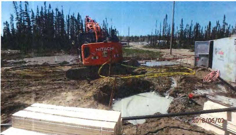
Photo 14: Remplissage du canal reliant les bassins
