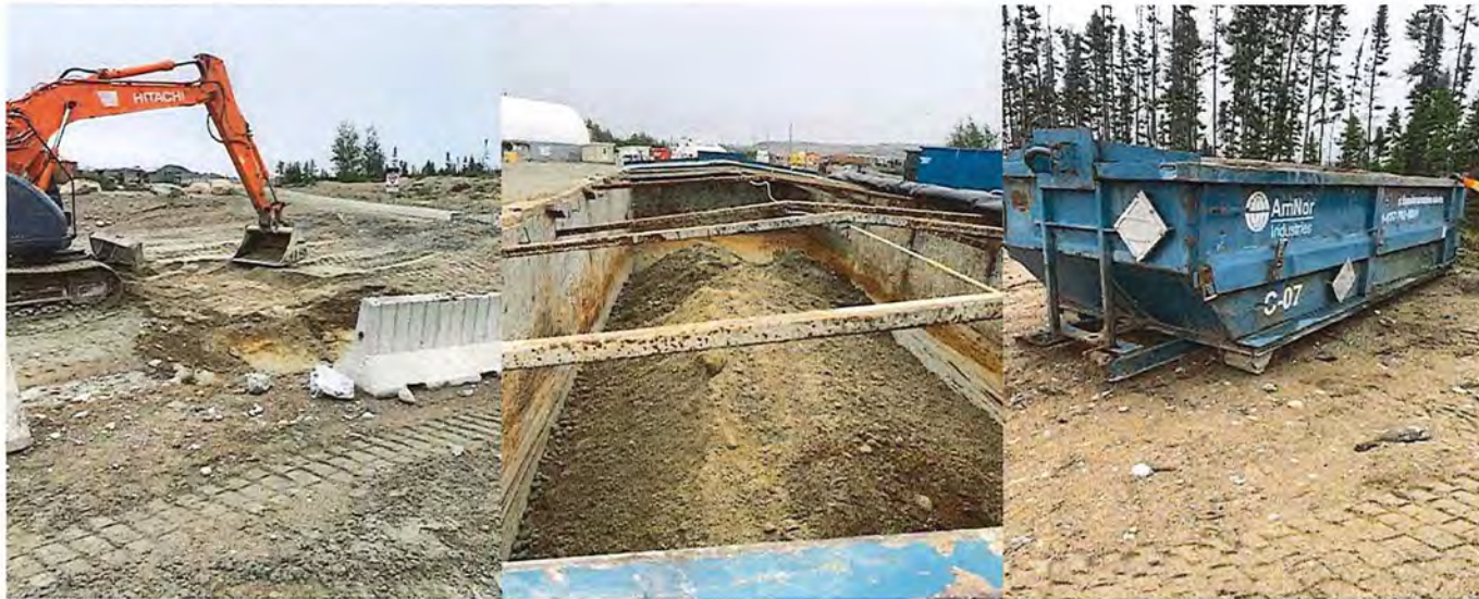
Nettoyage: Excavation et disposition sols contaminés dans conteneur Roll-off C-07
