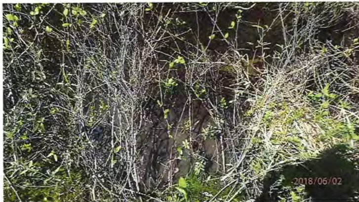
Photo 13: Nouvelle intrusion d'eau boueuse
