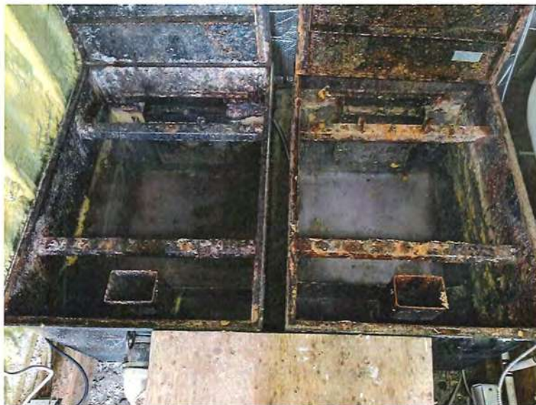
Photo 8 : Vidage complet des trappes à graisses (20jan)
