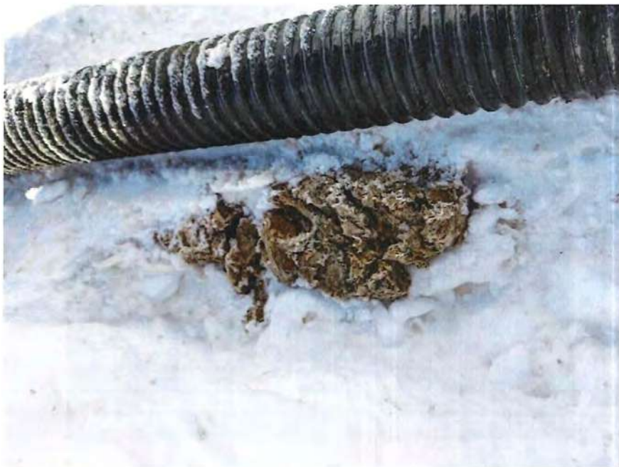
Photo 8 : Portion du bouchon de papier à main dégagé des cloisons de notre pré-fosse primaire le 18mars au matin
