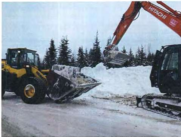
Photo 5: Remplissage d'un godet de 6 verges
