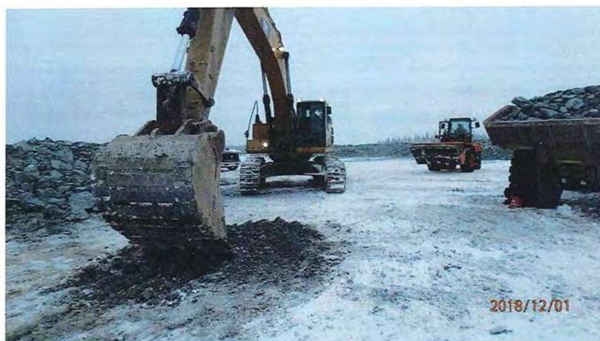
Photo 3 : Excavation de la roche souillée avec pelle mécanique
