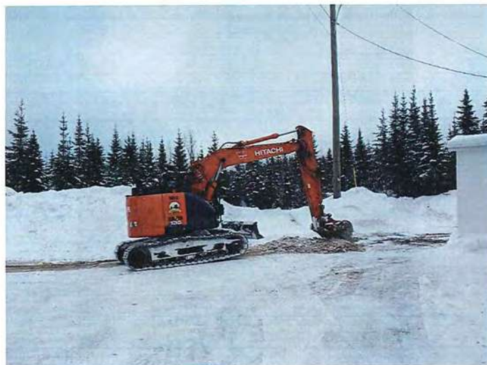
Photo 4: Excavation en cours
