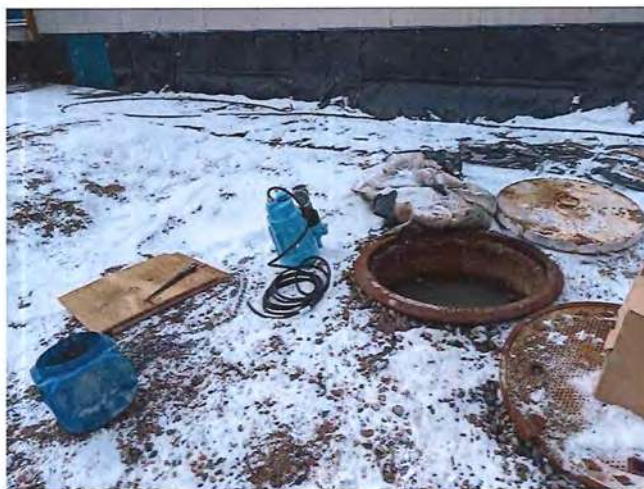
Photo 4: Installation d'une pompe temporaire pour transférer le surplus d'eau pour cesser le déversement.
