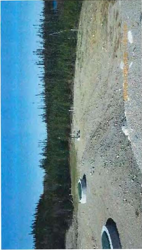
Photo 6 : Champs d'épuration utilisés en alternance.
