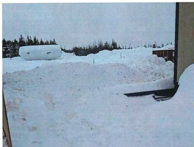
Photo 7: De la neige fut resoufflée sur la zone qui avait été déneigée à proximité de la conduite bouchée (19jan)
