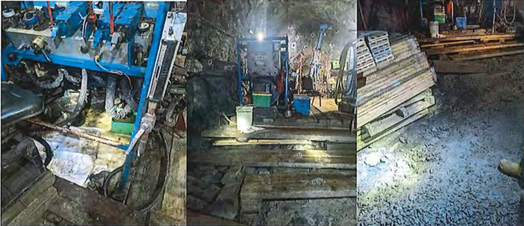
Photo 3 : Présence d'huiles vers puisard
