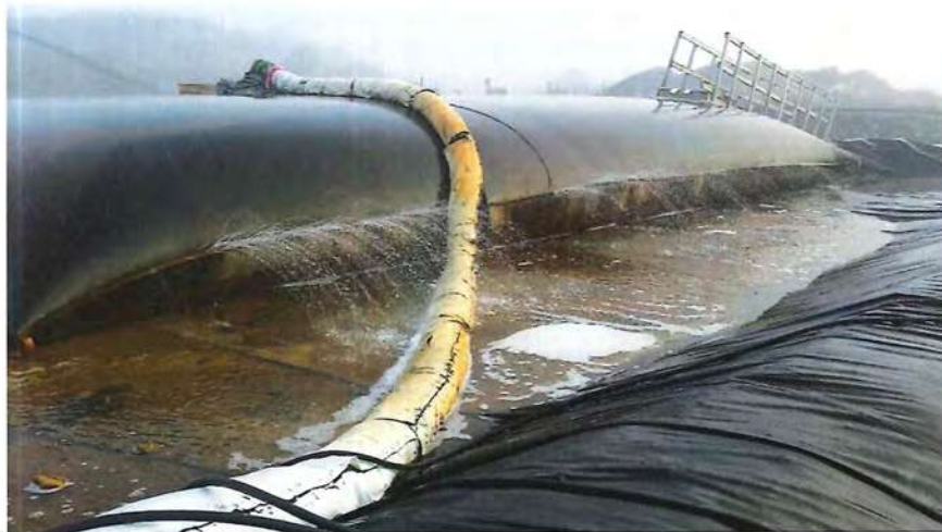
Photo 2: mousse apparente à la sortie du géotube vers 7h du matin
