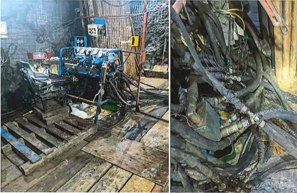
Photo 2. Absorbants et lieu du déversement
