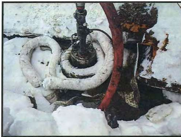
Photo 3 : enrobage préventif de la pompe submersible pour éviter de rejeter des résidus d'huiles plus loin
