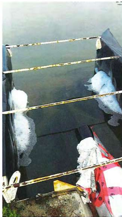
Photos 3 et 4 : mousse dans le bassin de polissage
