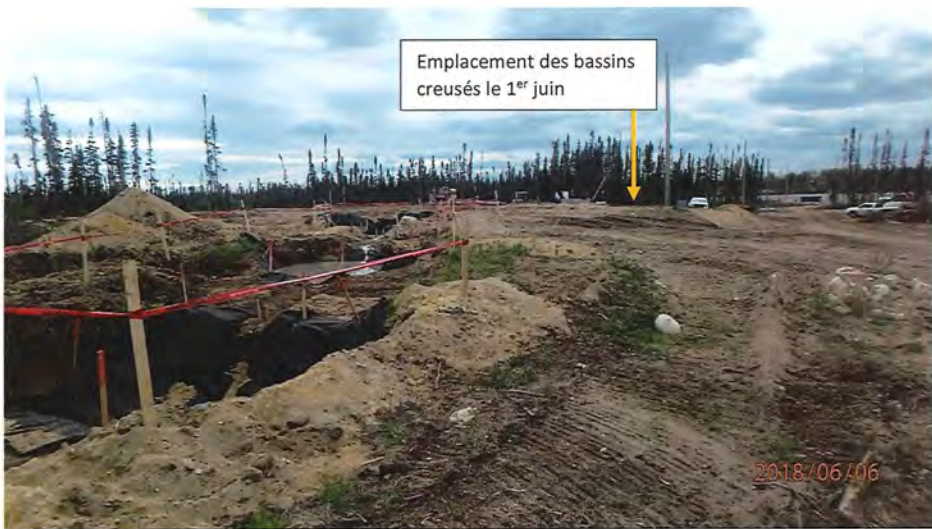
Photo 16: Nouveaux bassins en utilisation depuis le 2 juin
