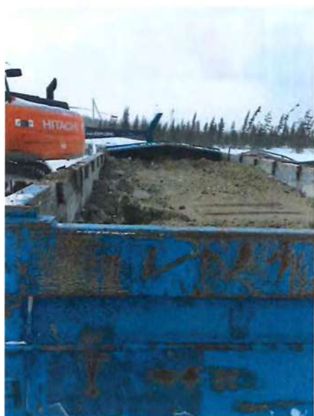
Récupération sol contaminé
