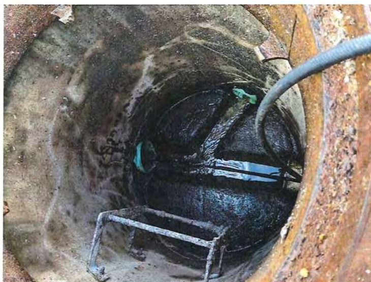
Photo 5: Trou d'homme (en ligne avec les trappes à graisse) débouché
