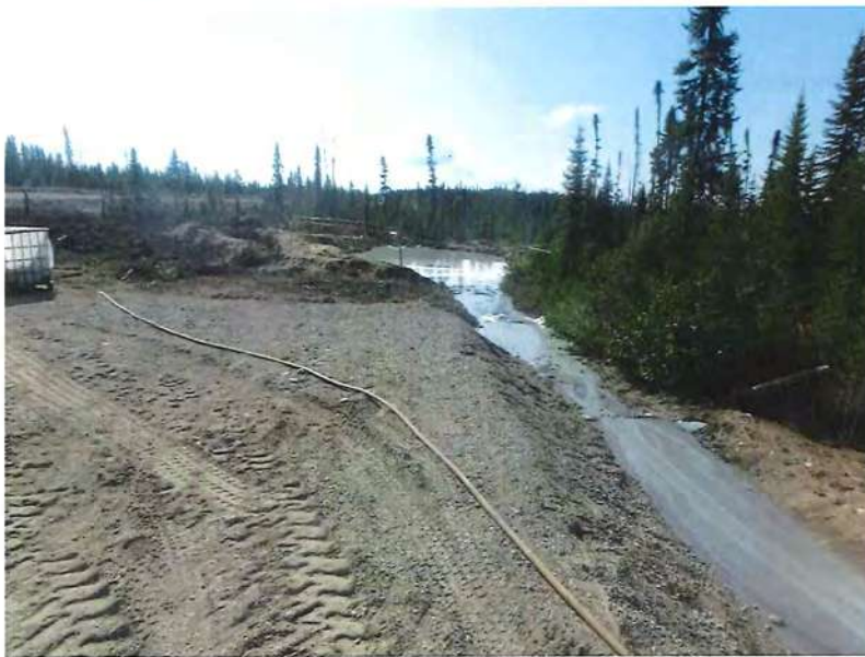
Photo 2: fossé et bassin de rétention d'eau
