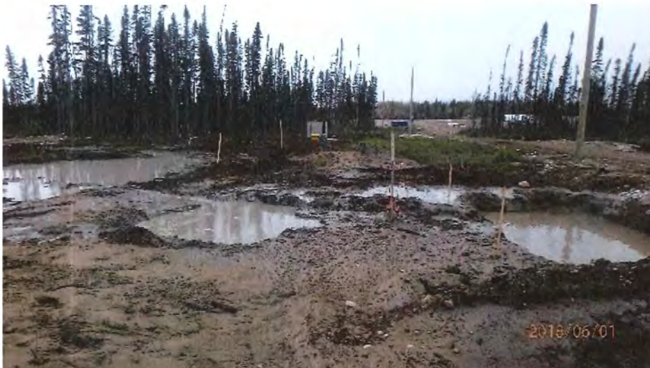
Photo 7: Bassins creusés à proximité de la foreuse #52 de sorte à drainer dans la direction opposée l'eau accumulée en bordure du boisée.
