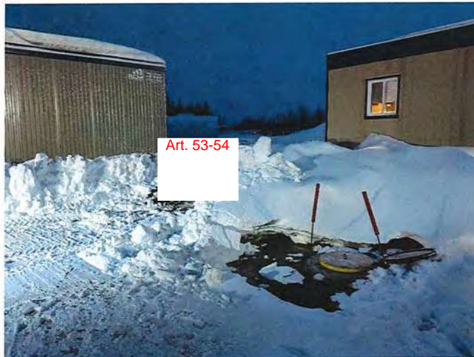
Photo 2: dégagement du 3ème manhole en ligne avec les 2 trappes à graisse
