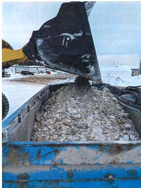
Photo 6 : déchargement du contenu du godet dans le conteneur C-24
