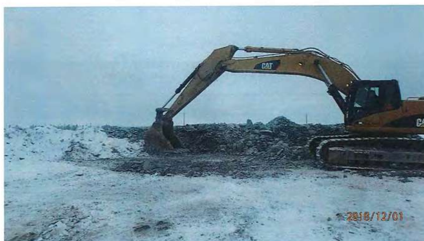
Photo 4 : Excavation finale remplie de roche propre à la fin du nettoyage
