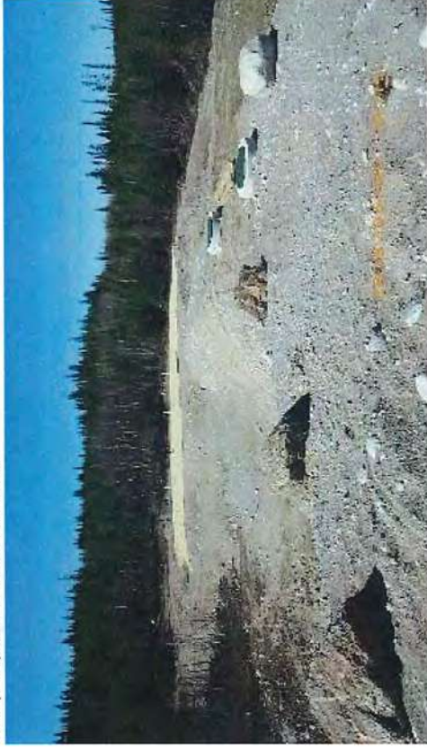
Photo 6 : Champs d'épuration utilisés en alternance.
