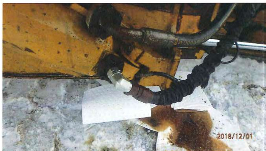
Photo 6: Connecteur réparé sur place
