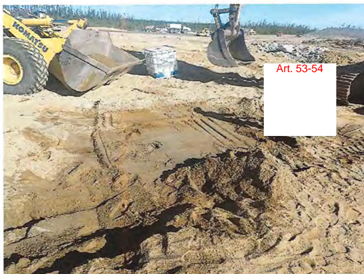
Photo 5: excavation du sol contaminé
