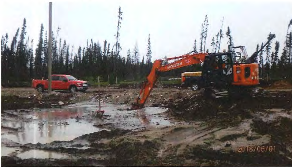
Photo 6: Début de l'excavation des bassins.
