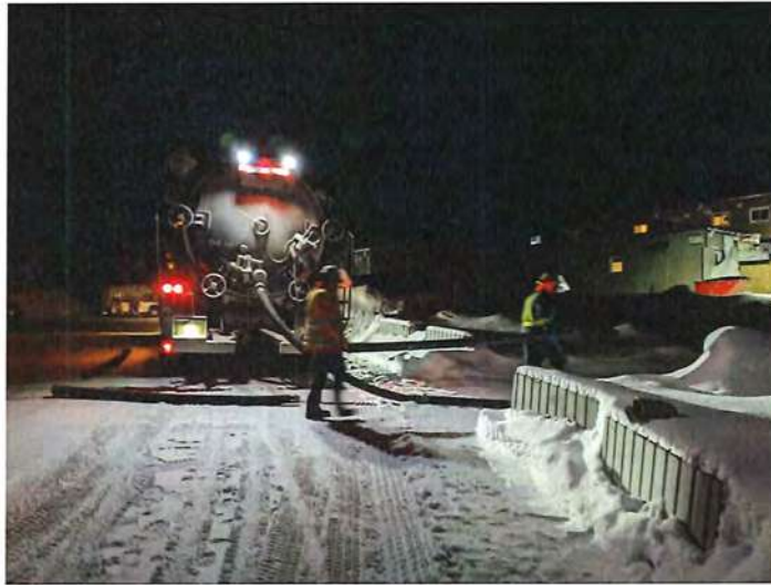
Photo 4 : Aspiration du surplus de boue sanitaire le soir de l'arrivée de Véolia (18jan)
