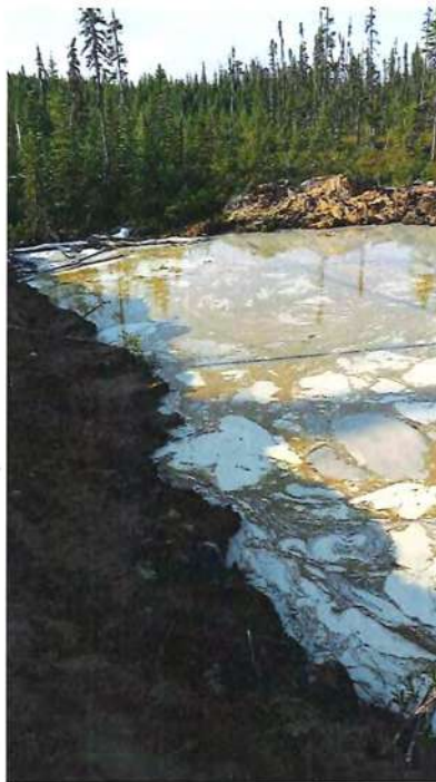
Photo 11: État du bassin de rétention le 8 août à 8h
