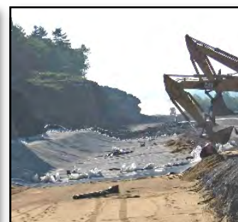
IMPERMÉABILISATION DE FOSSE
