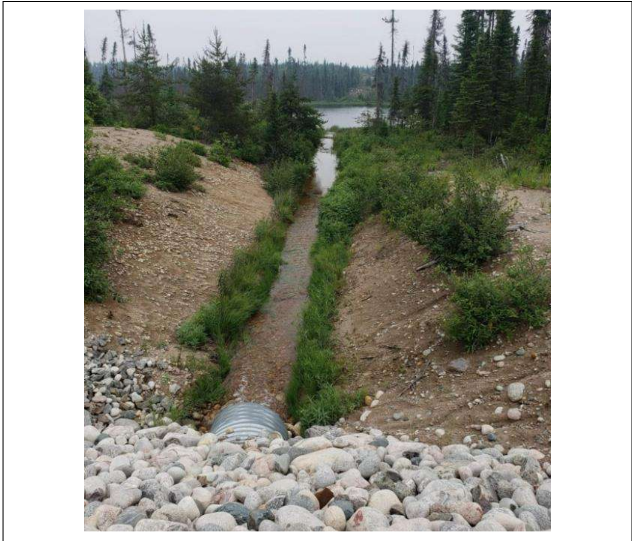
Photo 1-1 Aménagement du canal de l'effluent actuel
