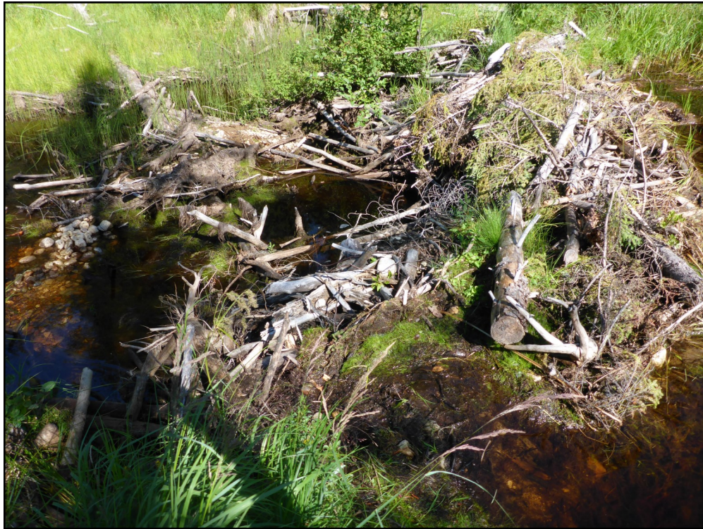
Photo 17 Ancien barrage de castor, segment S05, cours d'eau CE06B (2016)
