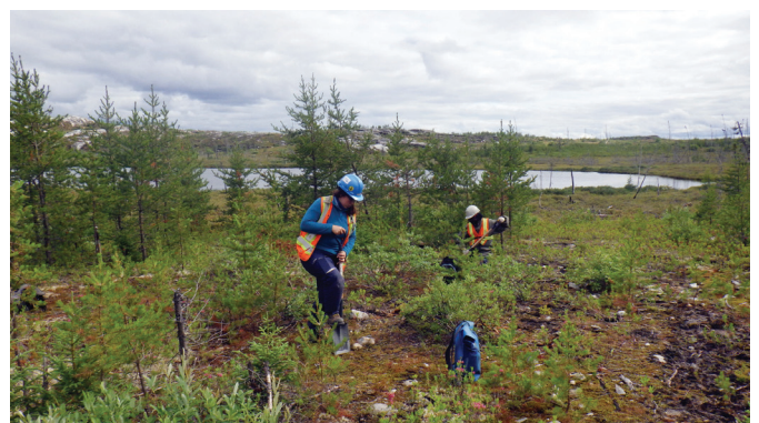
Photo 15 - Zone P-20 – Sondages en cours de fouille sur la zone P-20 – Vue vers l'est (GALAXY21-N1-094)
