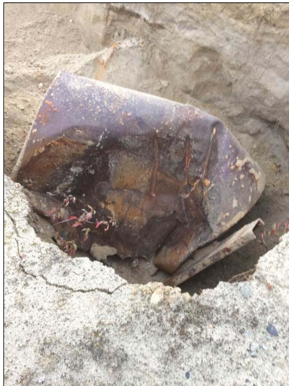
Photo B-2 : Réservoir vide dans la tranchée d'exploration CE-TR5
