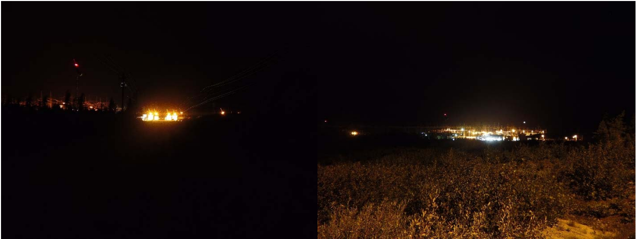
Photo 6-1 Lumière à l'entrée du poste électrique de la Nemiscau
