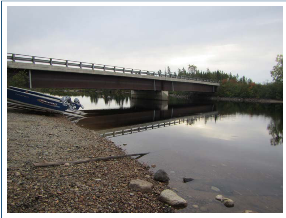
PHOTO 13 — Rivière Nemiscau vue du pont de la route du Nord vers l'amont
