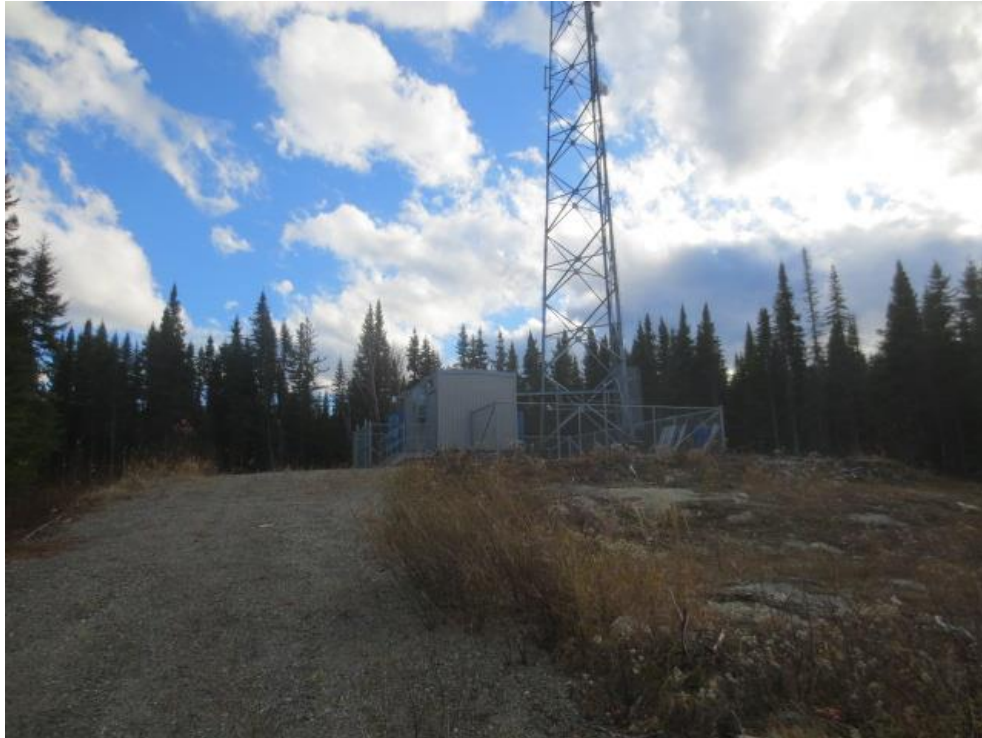
Photo 3 : Visée direction nord montrant la tour de télécommunication existante localisée entre la cartotheque et le secteur de l'usine, à l'entrée du site.
