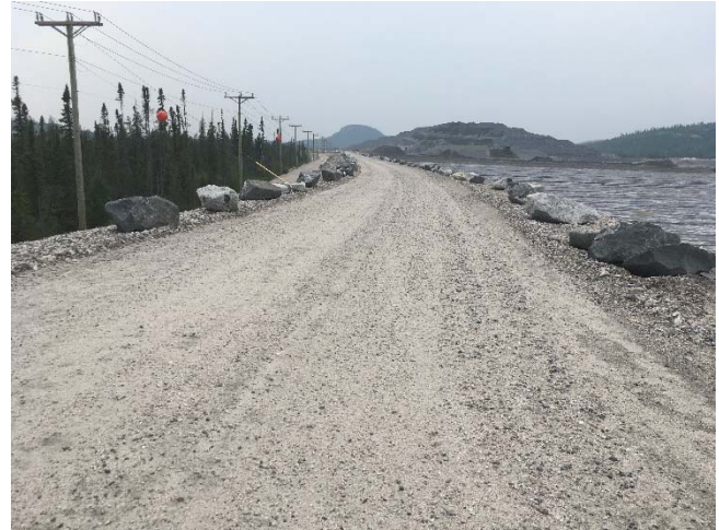
Photo 2 : Crête de la digue d'amorce et l'intérieur de la phase 2 du PAR, vue vers l'ouest.
