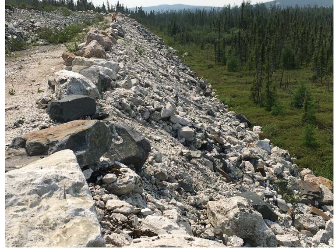
Photo 30 : Aire d'entreposage de la tourbe de la phase 1. Le talus aval de la digue (pente raide), côte nord.
