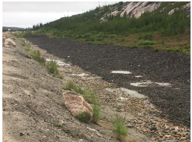
Photo 20 : Fossé intercepteur nord (côté est). Vue vers l'ouest.
