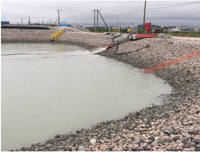
Photo 1 : UTEI, Bassin de sédimentation : Vue du bassin du côté sud.
