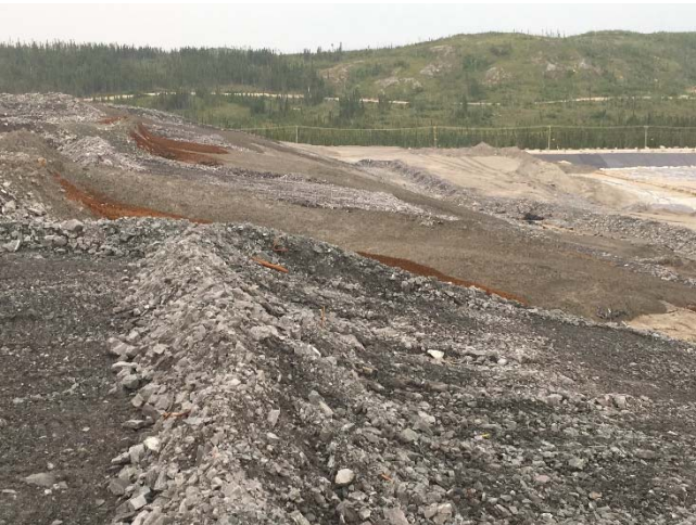
Photo 11 : Phase 1 du PAR. Drain central et déposition de la boue au-dessus de l'enrochement en intervalles. Vue vers le sud.
