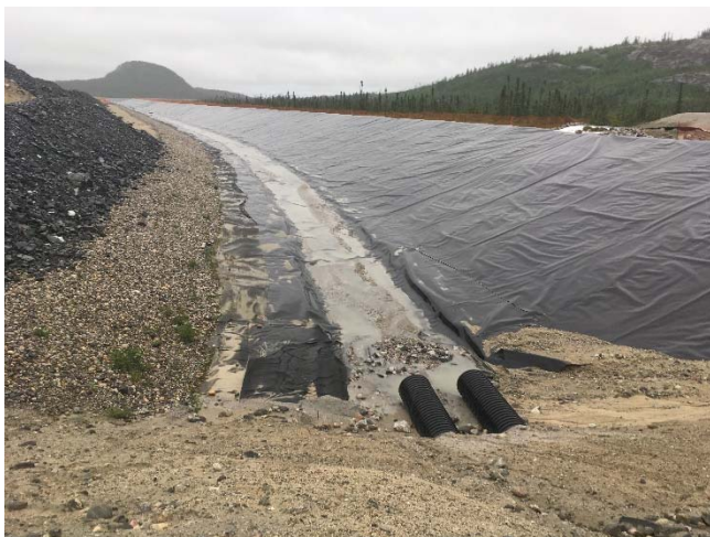
Photo 23 : Fossé de transfert, vue vers l'ouest.
