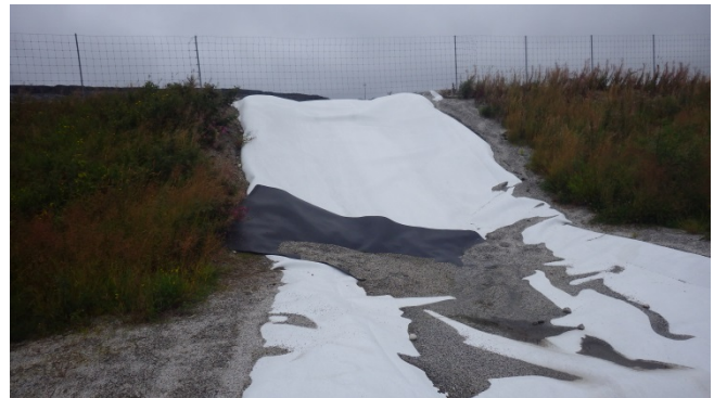
Photo 28 : Halde à stériles, BEC : Vue du déversoir (géomembrane blanche), côté sud du bassin.
