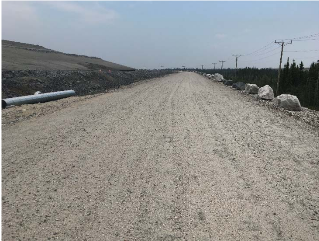
Photo 1 : Crête de la digue d'amorce du phase 1 du PAR, vue vers l'est.
