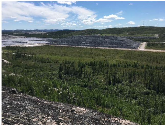
Photo 22 : Halde à stériles et phase 2 du PAR. Vue vers le sud.
