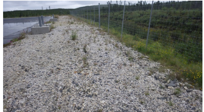
Photo 38 : Bassins des eaux usées, no.2 : Vue du fossé vers l'ouest.
