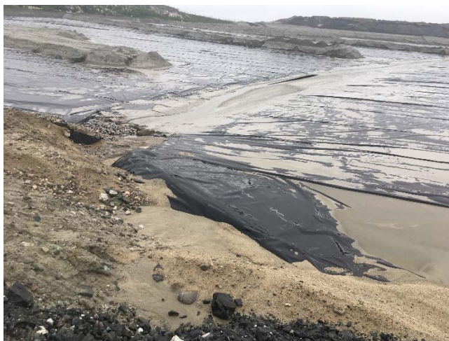
Photo 16 : Phase 2 du PAR. Fossé de transfert rempli avec des résidus. Vue vers l'est (de la digue temporaire entre les phases 2 et 3).
