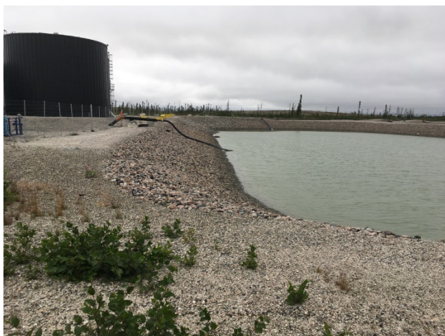
Photo 11 : UTEI, Bassin de polissage : Vue du déversoir et installation d'un nouvel équipement pour l'expansion de l'UTEI.
