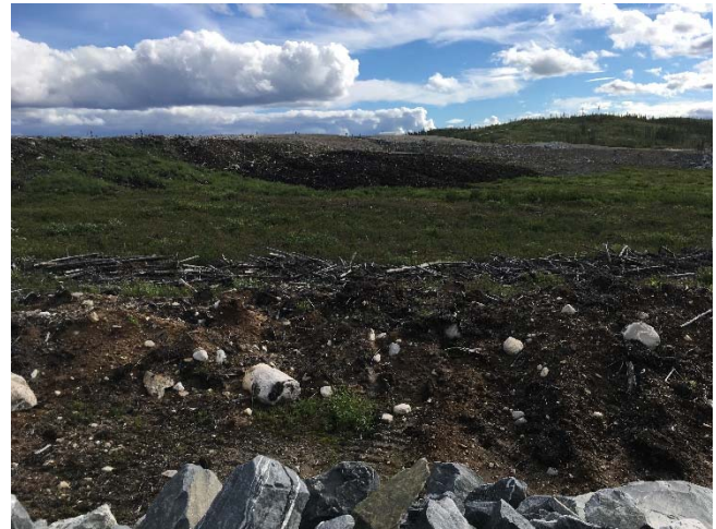
Photo 32 : Aire d'entreposage de la tourbe de la phase 2. Vue vers le sud.
