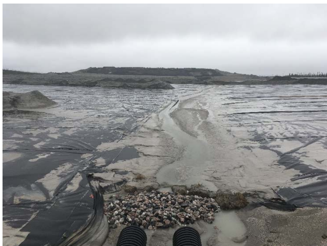
Photo 15 : Phase 2 du PAR. Fossé de transfert avec les résidus. Vue vers l'est (de la digue temporaire entre les phases 2 et 3).
