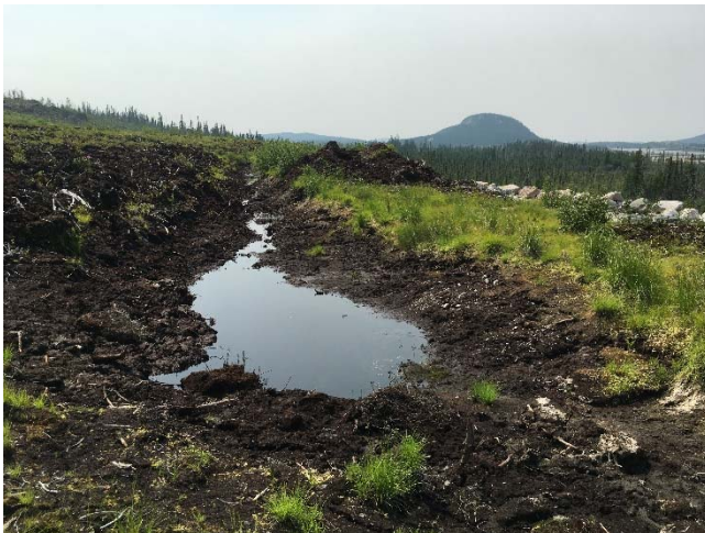
Photo 31 : Aire d'entreposage de la tourbe de la phase 1. Drainage d'eau à côté la digue est.
