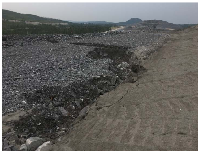
Photo 8 : Phase 1 du PAR. Pente aval et canal d'érosion sur la banquette. Vue vers l'ouest.
