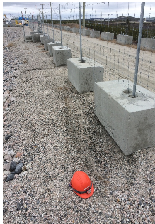
Figure 3 - Trou sur la crête de la digue côté Sud-Est
