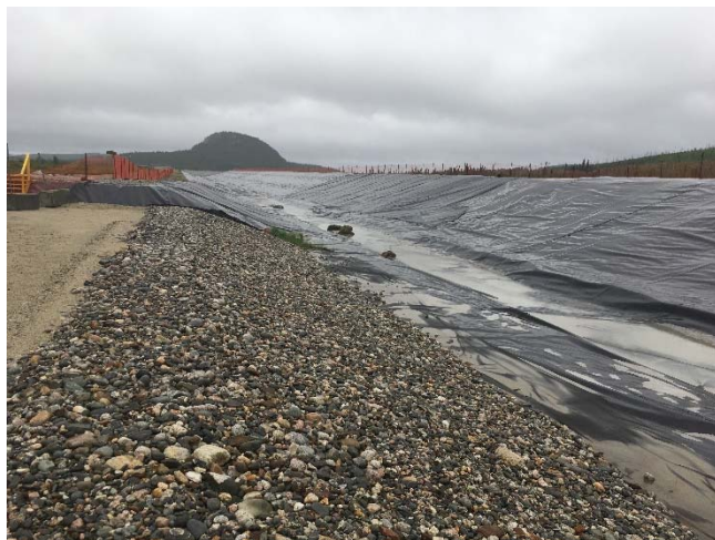
Photo 24 : Fossé de transfert, vue vers l'ouest.
