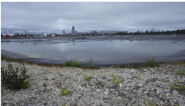
Photo 35 : Bassins des eaux usées, no.2 : Vue du bassin vers le nord.
