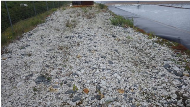
Photo 37 : Bassins des eaux usées, no.2 : La digue nord vers l'est.
