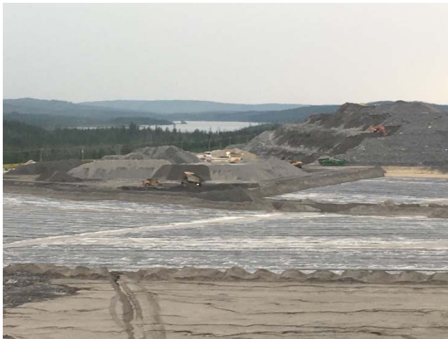
Photo 21 : Halde à stériles et phase 2 du PAR. Excavation des stériles avec les opérations de concassage. Vue vers l'ouest.
