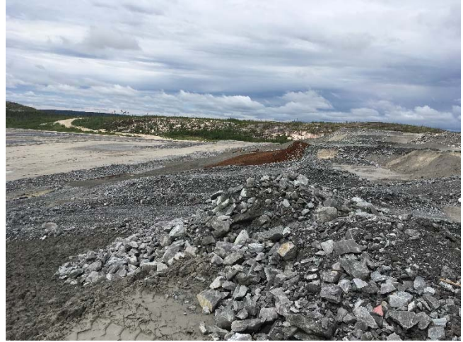
Photo 10 : Phase 1 du PAR. Drain central et les chemins d'accès construits avec de l'enrochement et déposition de la boue (brune). Vue vers le nord.
