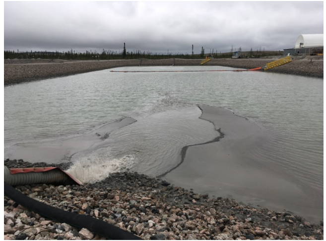
Photo 2 : UTEI, Bassin de sédimentation : Vue du bassin vers le nord.
