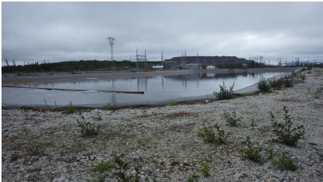
Photo 31 : Bassins des eaux usées, no.1 : Vue du bassin vers le sud-ouest.
