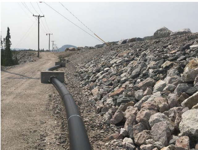
Photo 3 : Digue d'amorce et berme aval avec la conduite, vue vers l'ouest.
