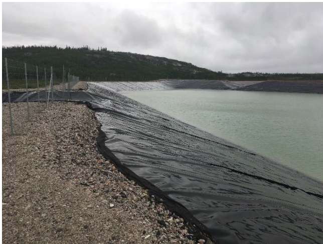
Photo 27 : Bassin de collecte d'eau. Crête de la digue d'amorce et le déversoir.
