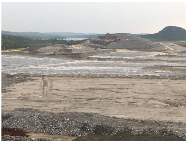
Photo 14 : Phase 2 du PAR et la halde à stériles. Vue vers l'ouest.
