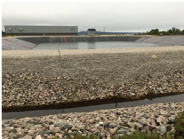
Photo 14 : UTEI, Bassin des eaux traitées : Vue vers le sud (de l'extérieur).
