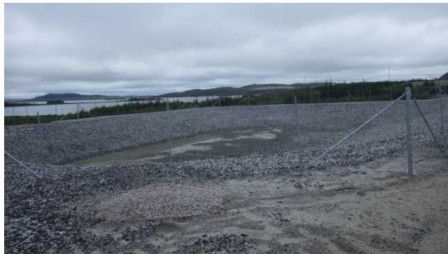
Photo 51 : Bassin des eaux de ruissellement, Zone 4 : Vue du bassin vers le nord-ouest.
