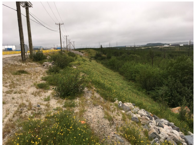
Photo 4 : UTEI, Bassin de sédimentation : La digue et la berme aval, vue vers l'est.
