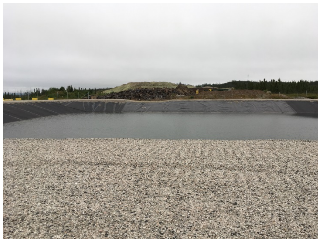
Photo 13 : UTEI, Bassin des eaux traitées : Vue vers l'ouest. Déversoir d'urgence est du côté ouest.
