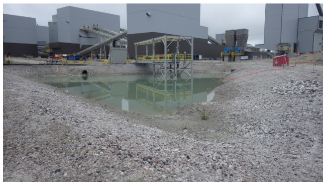
Photo 45 : Bassin des eaux de ruissellement, Zone 3 : Vue du bassin vers l'ouest.
