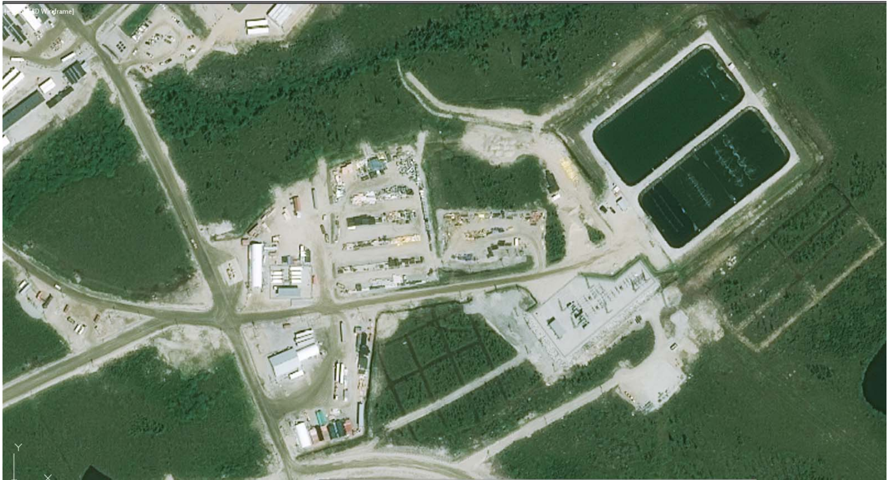
Figure B-3 - Bassins des eaux usées
