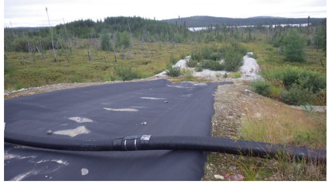
Photo 26 : Halde à stériles, BR1 : Vue du déversoir vers le sud avec le tuyau dans le déversoir.
