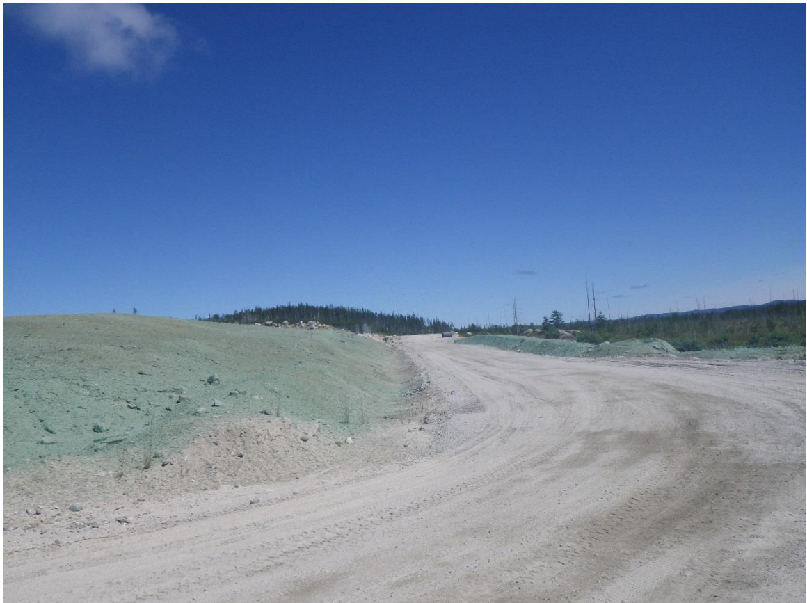
PHOTO 1 Hydro-ensemencement des cellules 1 et 2
