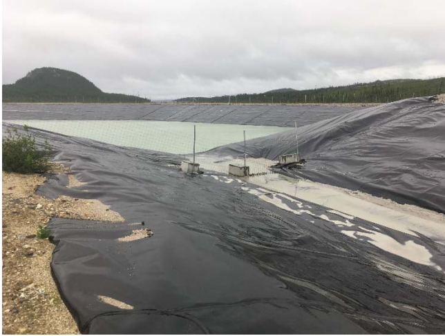
Photo 25 : Fossé de transfert et bassin de collecte d'eau. Vue vers l'ouest.
