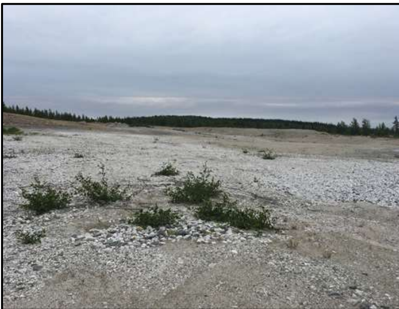
Figure 11: Sablière nivelée et concassé étendu (suivi des carrières-sablières, 2019-07-10)
