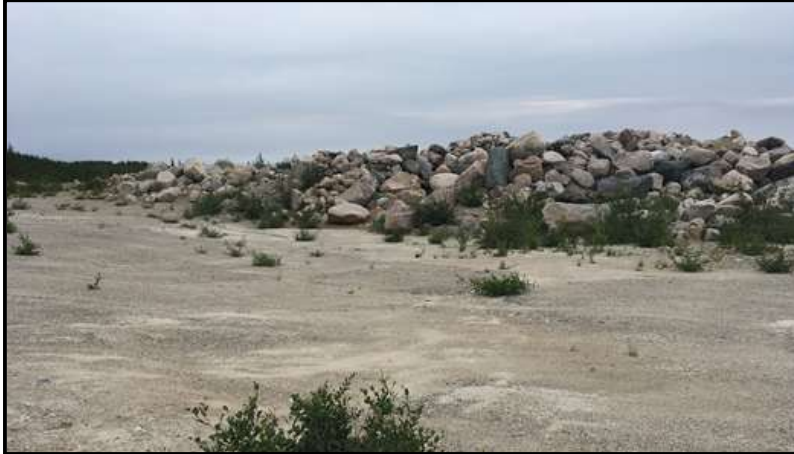
Figure 13: Présence de beaucoup de blocs à la sablière R36-B (Rapport inspection sablières, 2019-07-10)
