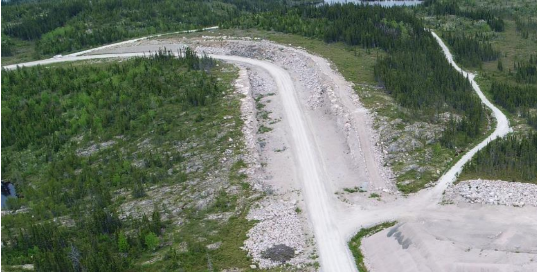
Figure 15 - Vue aérienne du tronçon de route d'hiver R6 à droite, de la route permanente au centre avec de part et d'autre, la carrière C-07, en 2017
