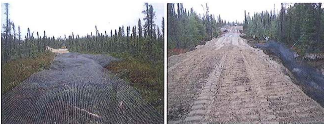
Figure 6 - Exemple de remblai sur géogrille (demande de CA du 26 novembre 2012)
