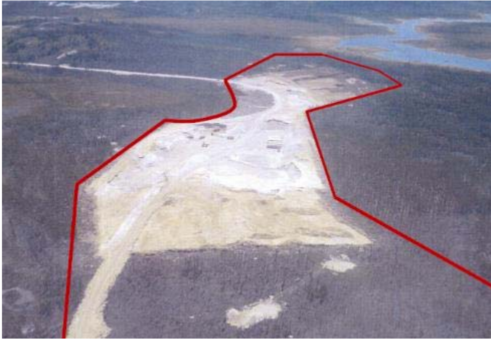
Figure 10 Vue aérienne de la sablière A-01-A
