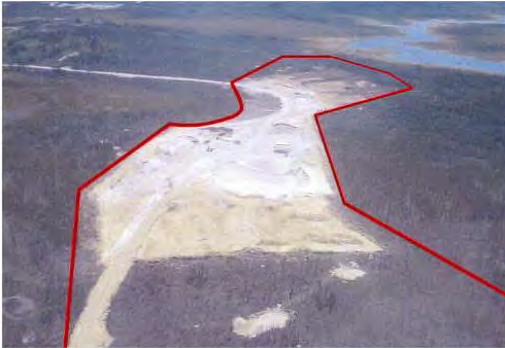
Figure 10 Vue aérienne de la sablière A-01-A
