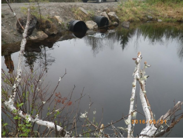
Photo 3.3 Vue de l'amont des ponceaux existants à remplacer (31 mai 2016)
