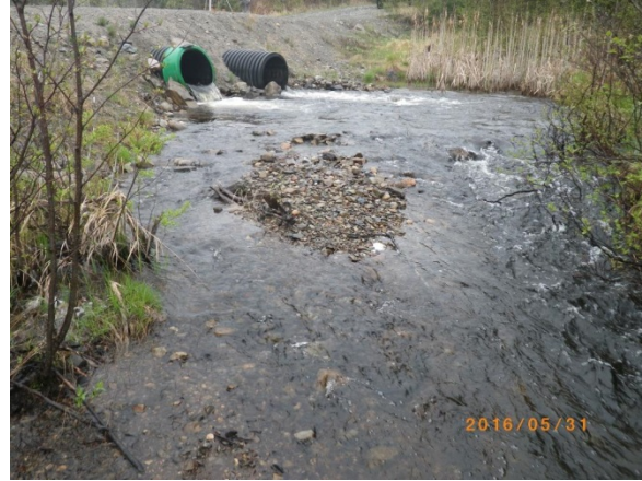
Photo 3.4 Vue de l'aval des ponceaux existants à remplacer (31 mai 2016)
