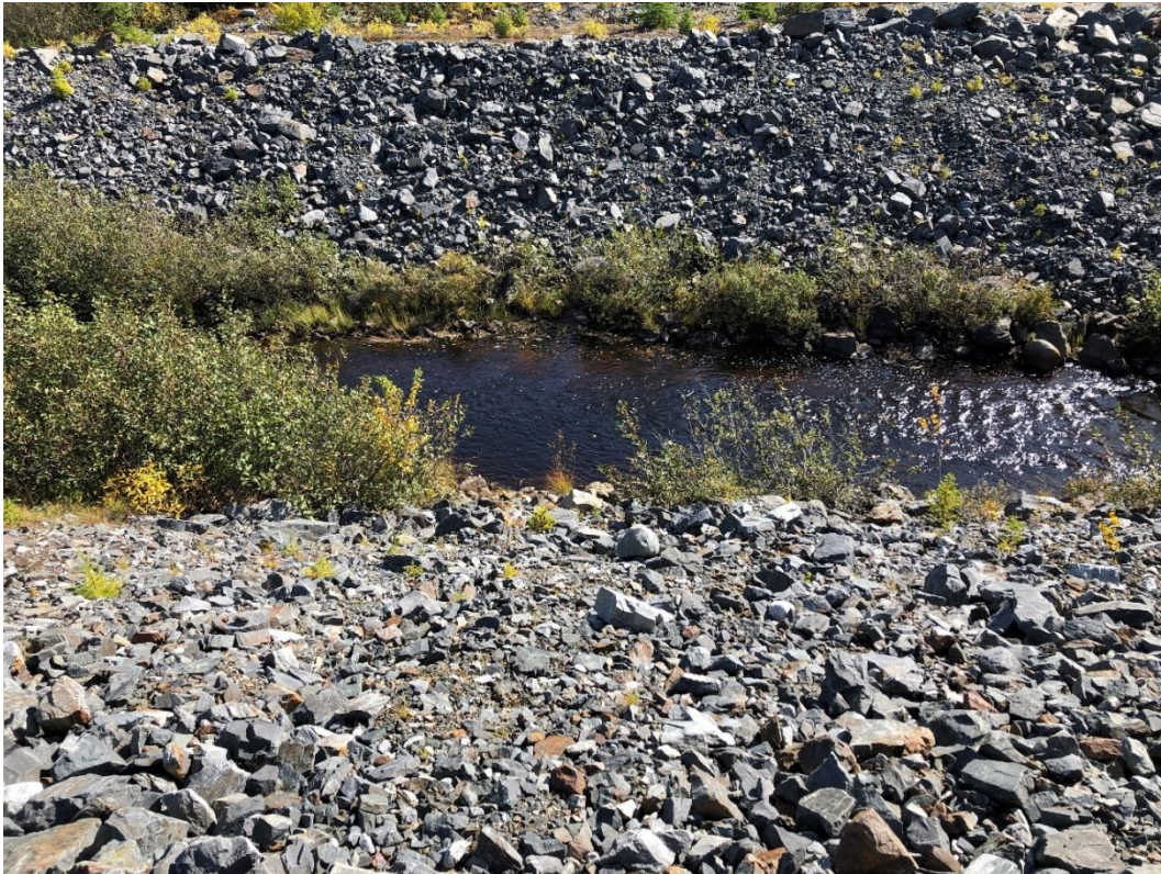
Photo 2 : Matériaux de remblai grossiers formant les rives du cours d'eau le long du segment 15 (DDM, 21 sept. 2019).
