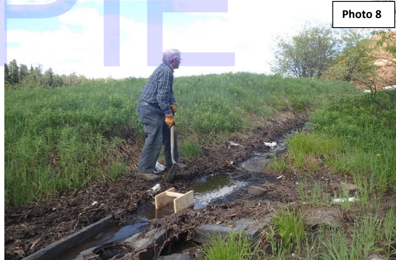
06/06/2017 – installation du déversoir triangulaire au PE-4
