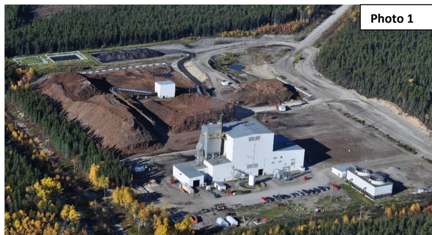
Photo aérienne de l'usine CHESEC en 2009
