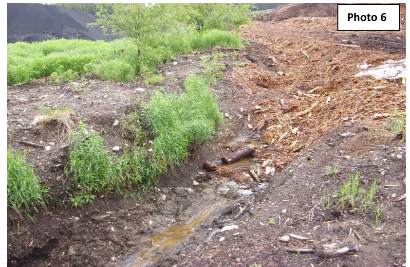
23/06/2008 – fossé le long de l’aire d’entreposage de la biomasse classifiée* avant la mise en place de Jersey blocks
