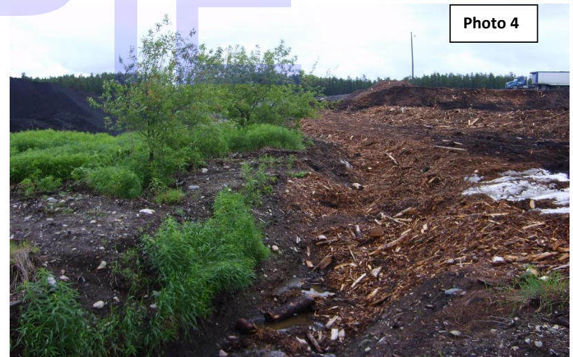
23/06/2008 – bordure de l’aire d’entreposage de la biomasse classifiée* s’accumulant dans le fossé de ruissellement
