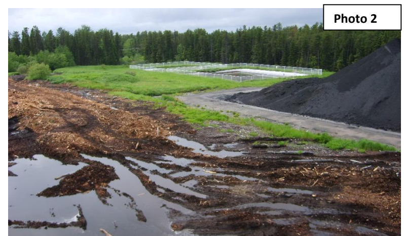
23/06/2008 – accumulation d'eau après la fonte des neiges le long de la biomasse classifiée
