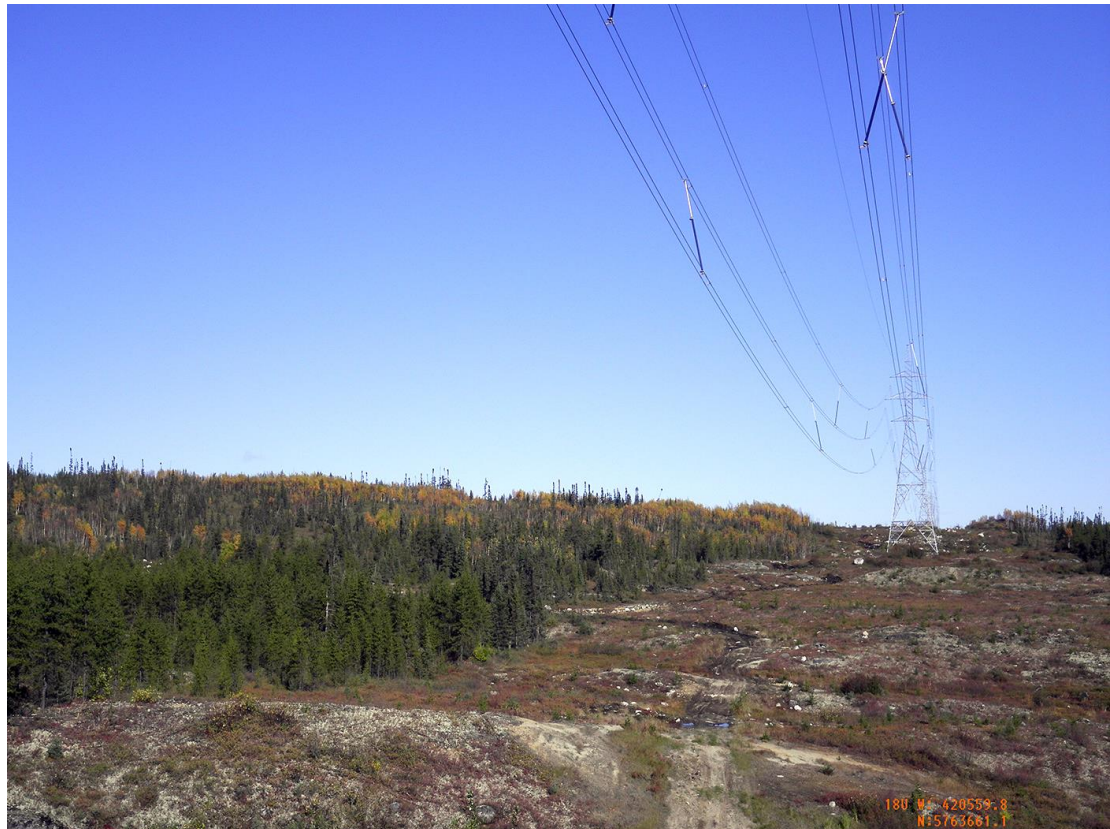
Photo 4-6 : Paysage de ligne de transport d'énergie
