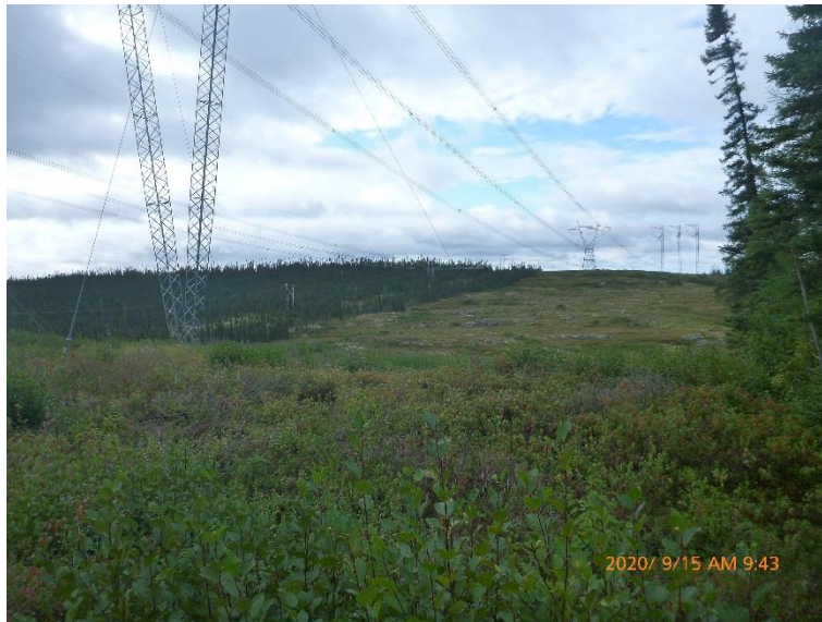
Photo 3 : Ligne de transport électrique à l'est (1/3)
