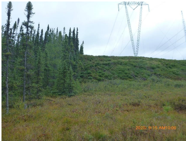
Photo 5 : Ligne de transport électrique à l'est (3/3)
