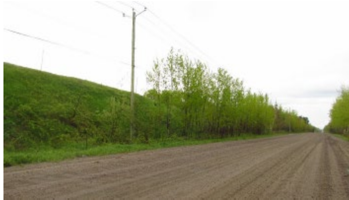
Photo 4-12 Talus au sud du site
