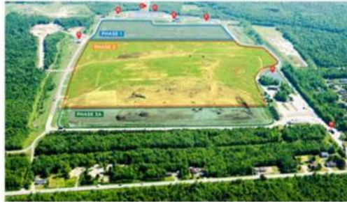
Principales infrastructures du site
