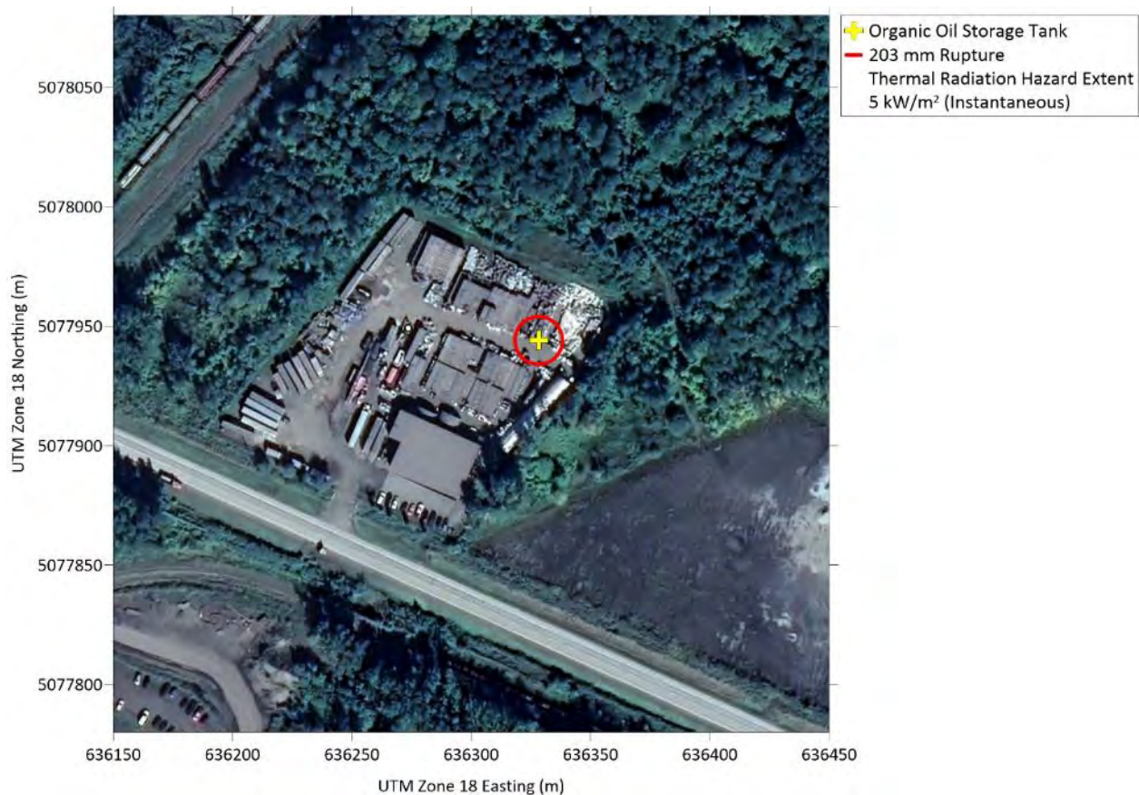
Figure B.15 Scénario pire cas (Rupture de 203 mm du réservoir d'entreposage de l'huile organique), Rayon d'impact de risque de rayonnement thermique (5 kW/m 2 ). Le scénario alternatif (Rupture de 76 mm) a un rayon d'impact similaire.
