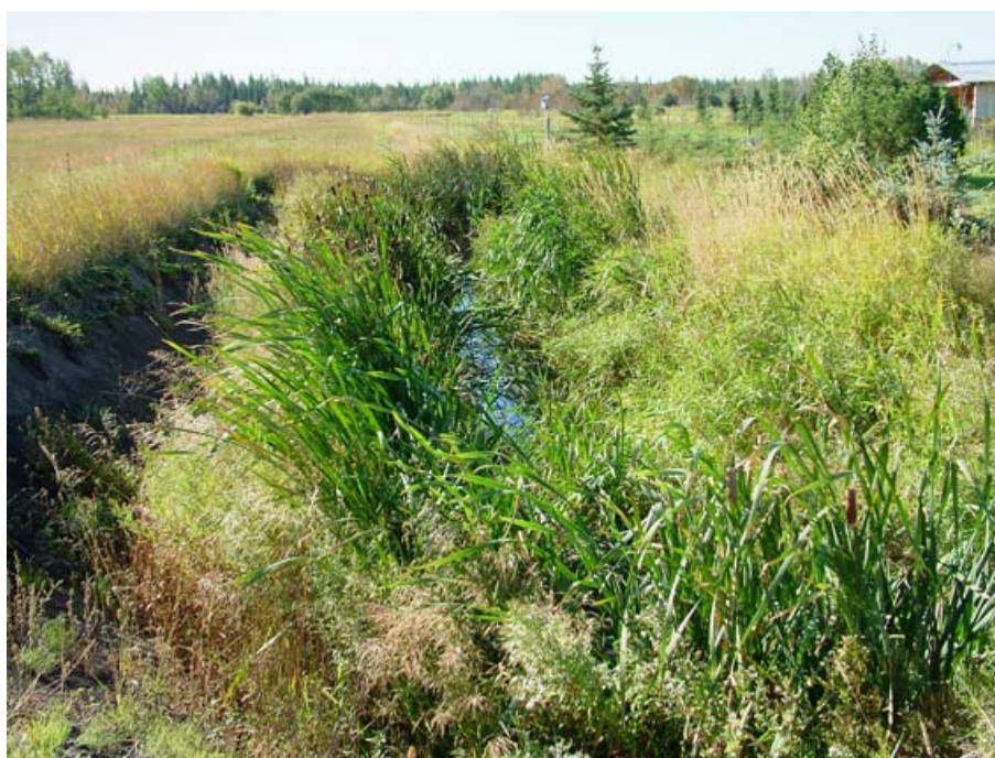
Photo 3 Marais filtrant des eaux usées de la résidence des propriétaires
