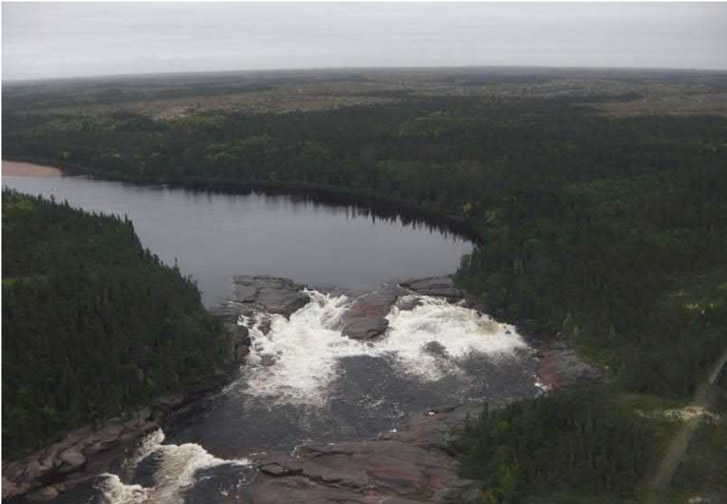
Photo 18. Vue aérienne de la Quatrième Chute de la rivière Aguanus
