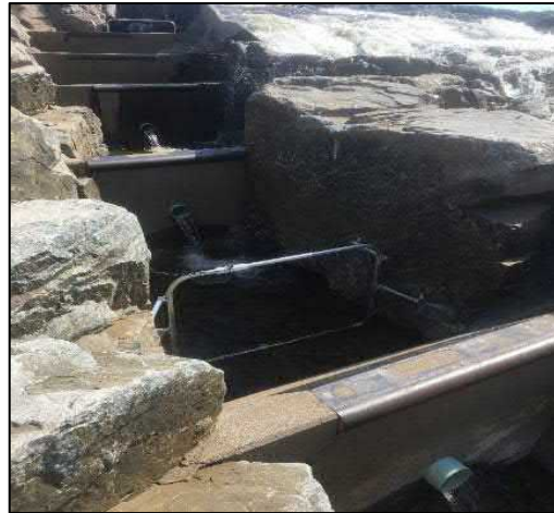
Photo 10. Antenne de détection sur la passe de Mingan pour détecter les PIT tag
