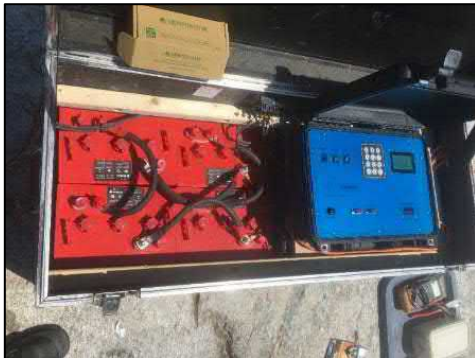
Photo 25. Système de détection Quadro
