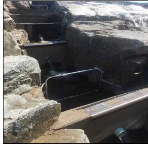
Photo 24. Antennes de détection sur la passe de Mingan pour détecter les PIT tag
