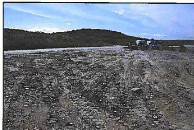
Photo LB2013_08_20_Lac_Jeannine_025 du mardi 20 août 2013. Début des travaux de plantation. Terrain plat, nivelé très récemment, au nord du nouvel exutoire de la Fosse 2. Il est maintenant couvert d'une multitude de jeunes plants d'arbustes.
