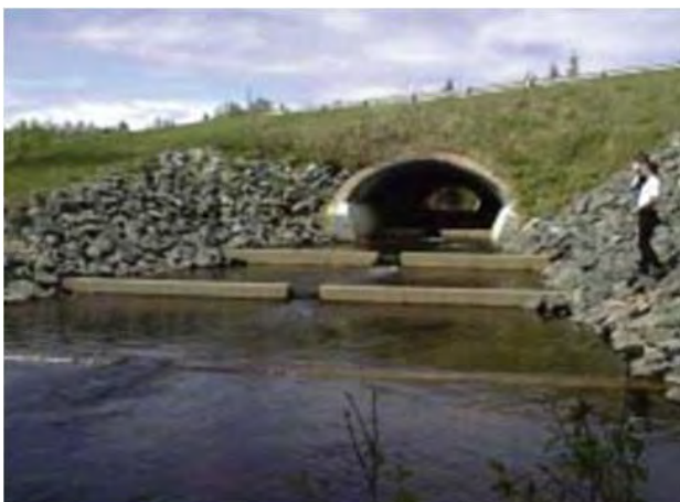
Photo 1. Exemples d'aménagements pouvant être réalisés en aval de ponceau infranchissable afin de restaurer la libre circulation des poissons
