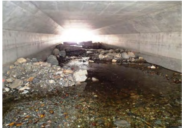
Photo 2. Exemples d'aménagements pouvant être réalisés à l'intérieur de ponceau infranchissable afin de faciliter la libre circulation des poissons
