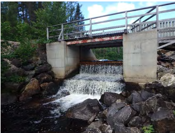
Photo 6. Chute dans le déversoir qui crée un obstacle infranchissable pour le poisson
