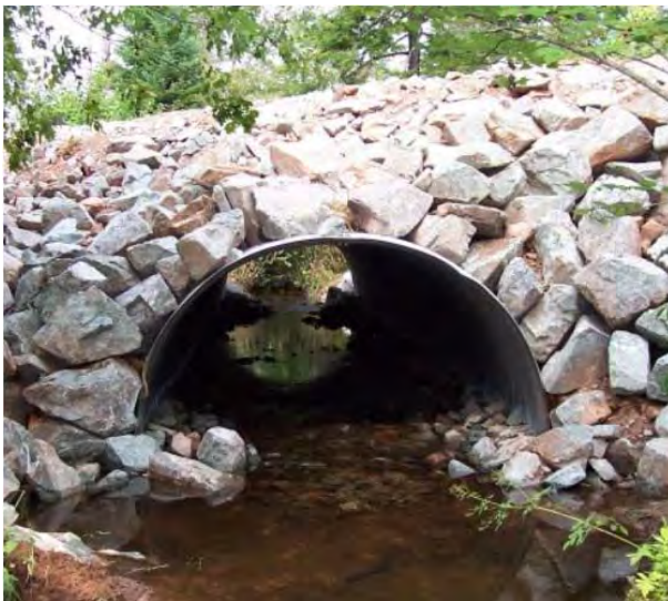
Photo 3. Exemples de ponceau conçu pour assurer la libre circulation des poissons
