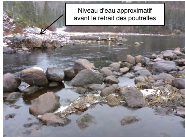
Photo 5. Niveau d'eau abaissé de 1 m à la suite du retrait des poutrelles
