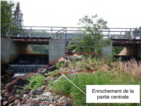
Photo 4. Vue générale du barrage du lac à la Loutre. L'engrochement de la partie centrale a été emporté par la crue de 2008
