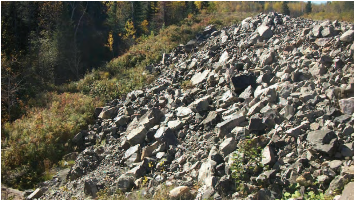
Photo 2.2 : Vue montrant le remblai de pierre dynamitée au droit d'une zone de pente bordant le chemin d'accès
