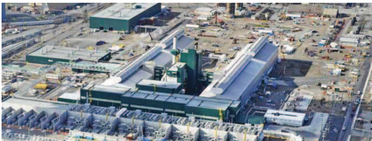
Figure 1: Vue aérienne de l'usine AP60
