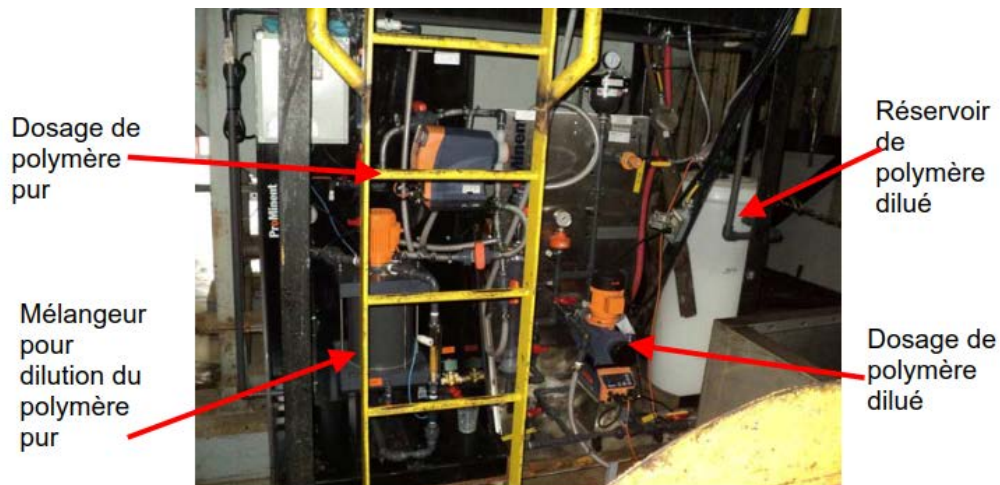
Figure 5-2 : Système de dosage de polymère d'une unité GEM
