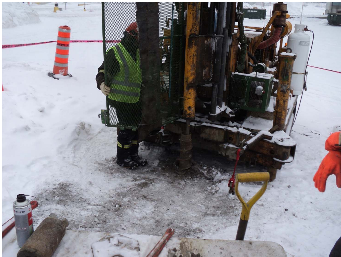
D\ c h % . Foreuse en opération lors de la réalisation d'un forage
