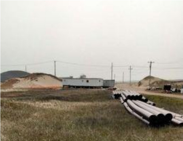
Photo 19. Route d'accès, unité U029
