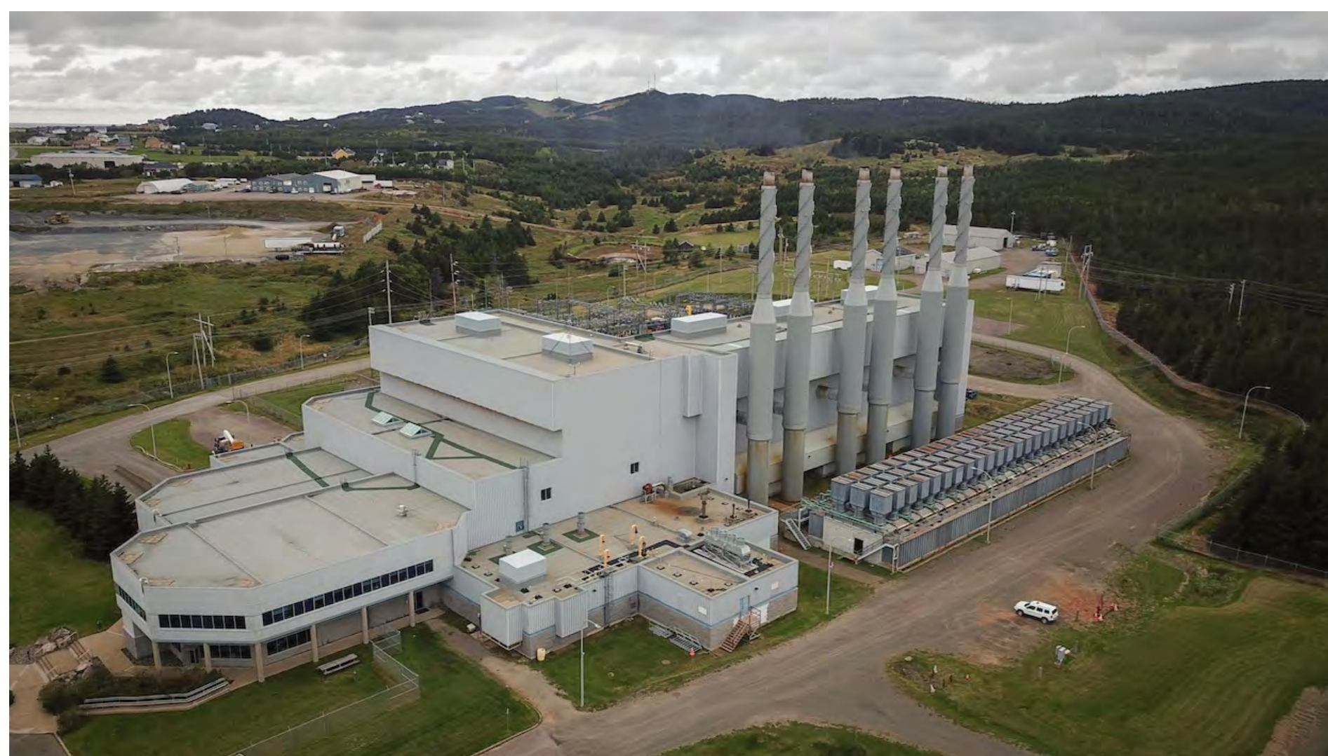
Photo de la Centrale d'Hydro-Québec, Cap-aux-Meules, © Photo Radio-Canada
