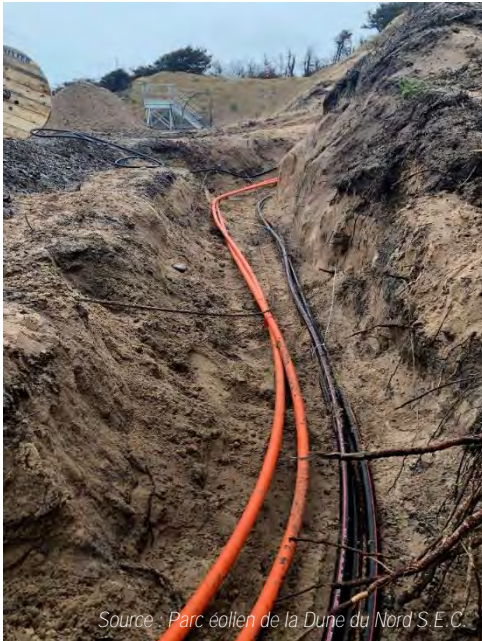
Figure 6. Installation d'un réseau collecteur souterrain
