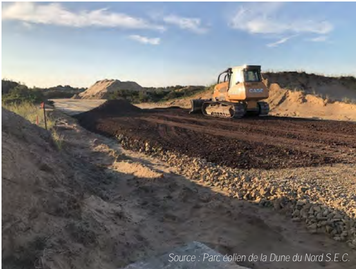
Figure 2. Amélioration d'un chemin en milieu dunaire
