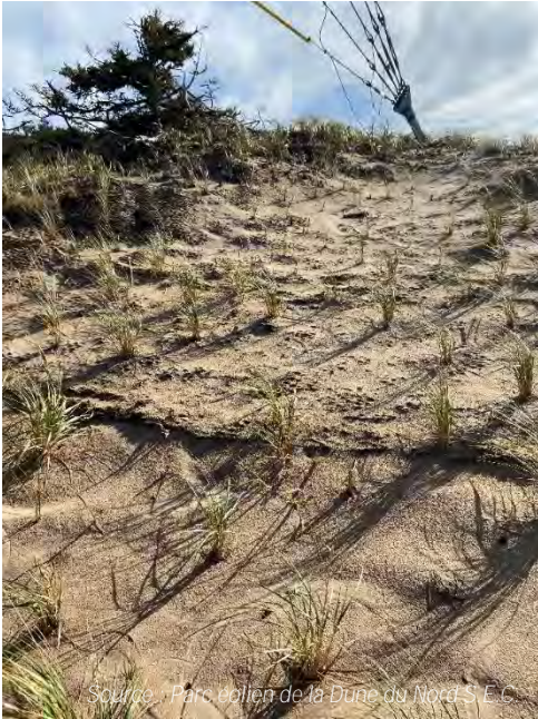
Figure 7. Tapis de cocoensemencés d'ammophile à ligule courte lors de la stabilisation du milieu dunaire
