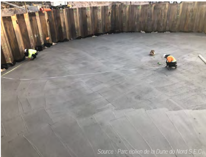
Figure 4. Construction d'une fondation circulaire d'éolienne
