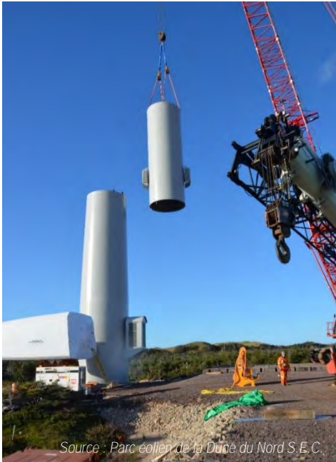
Figure 5. Assemblage d'une tour d'éolienne par section
