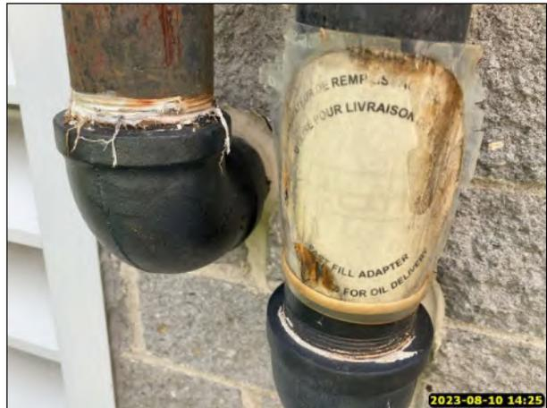
Tuyaux de remplissage et d'évent d'un système au mazout présent dans la station de traitement des eaux (#10) (Secteur Lac-Mégantic).
