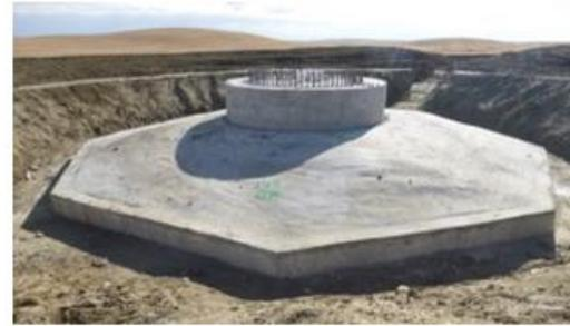
L'excavation des fondations est d'un diamètre d'environ 25 mètres. Une quantité d'environ 400 à 800 mètres cube de béton est nécessaire pour la fondation de chaque éolienne.
