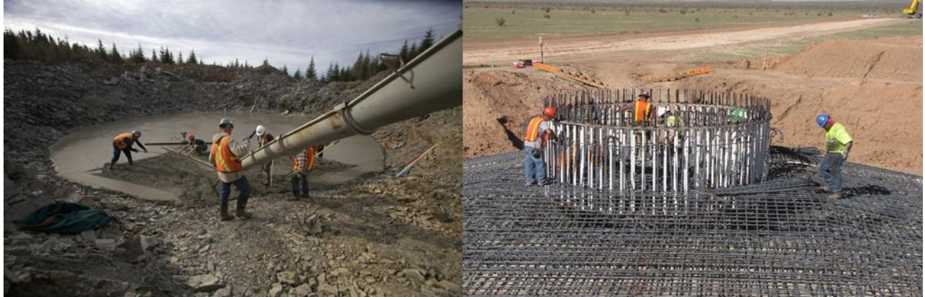
Figure 4-6 – Mise en place de la fondation d'une éolienne (source : EDF)
