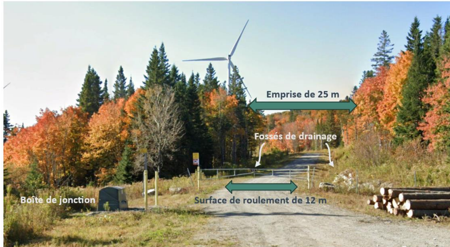
Figure 4-3 - Exemple de chemin d'accès pour accéder aux sites des éoliennes à la phase d'exploitation (source : Google Earth)
