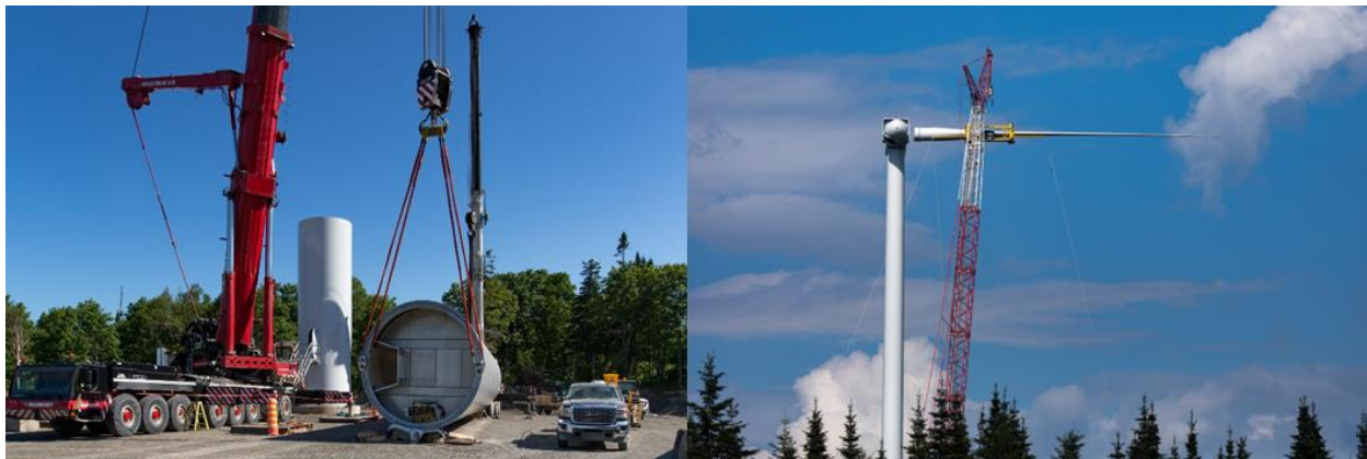
Figure 4-7 - Montage des éoliennes (source : EDF)
