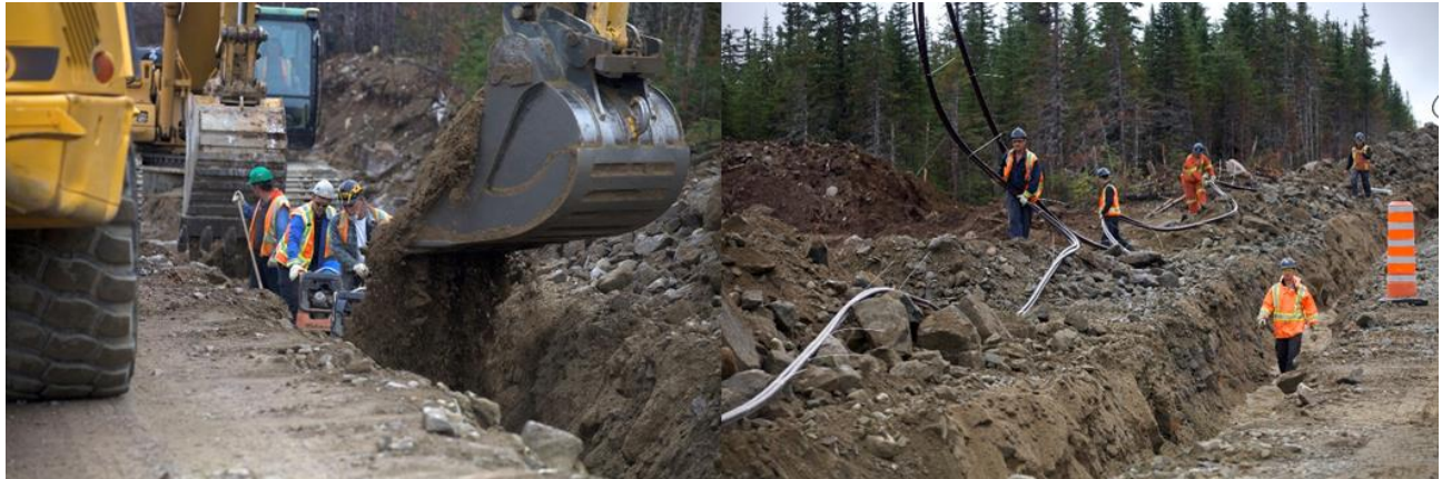
Figure 4-8 - Installation du réseau collecteur (source : EDF)
