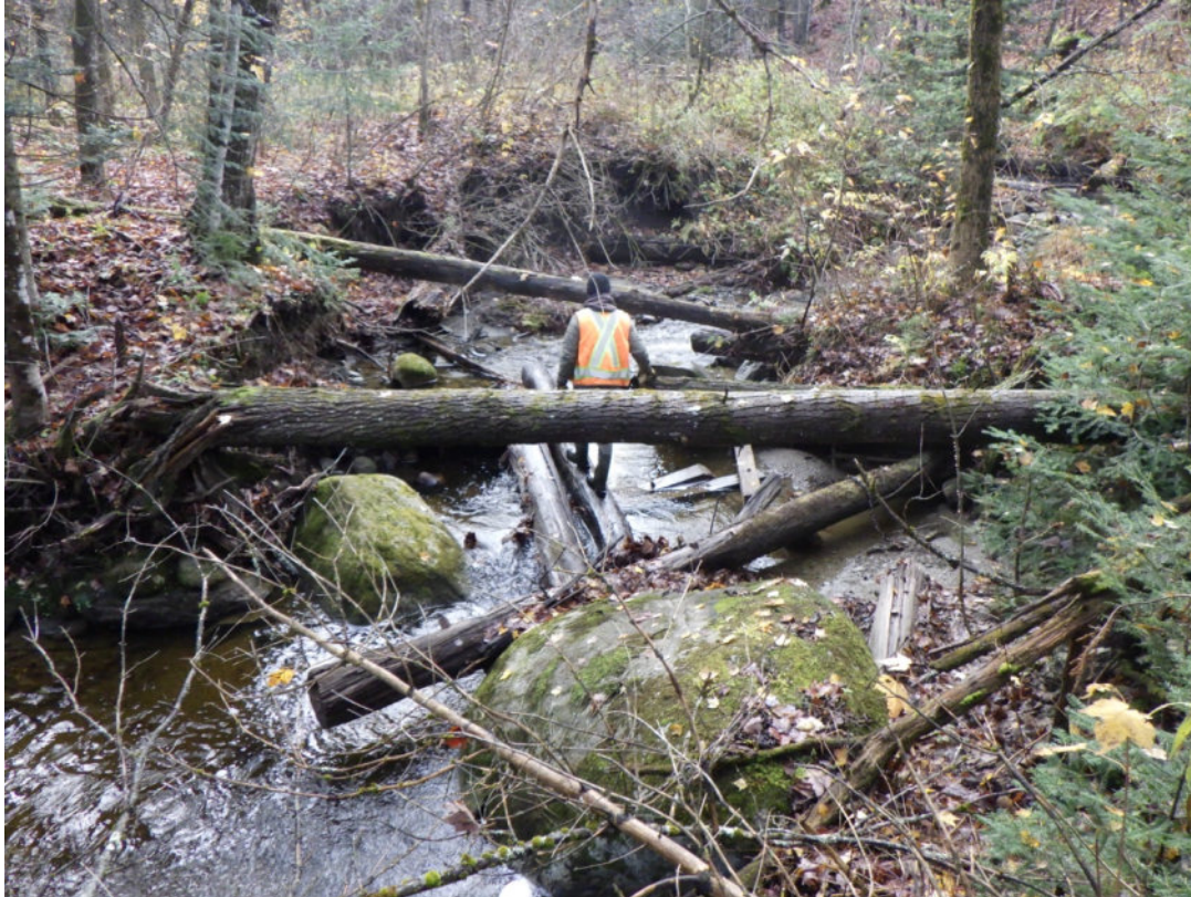
Photo 5 Vestiges du barrage en bois (photo prise vers le sud-est)
