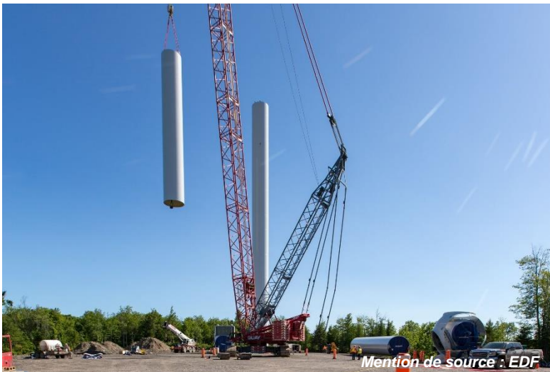
Figure 6. Assemblage d'une tour et d'une pale d'éolienne
