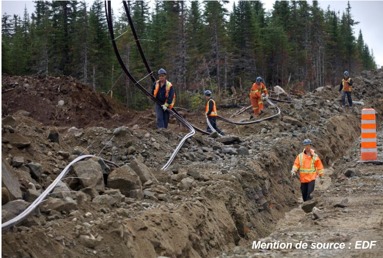
Figure 7. Installation d'un réseau collecteur souterrain
