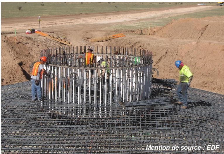
Figure 5. Construction d'une fondation d'éolienne de type gravitaire
