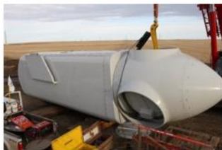
Installation de la nacelle
