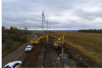
Enfouissement du réseau collecteur.
