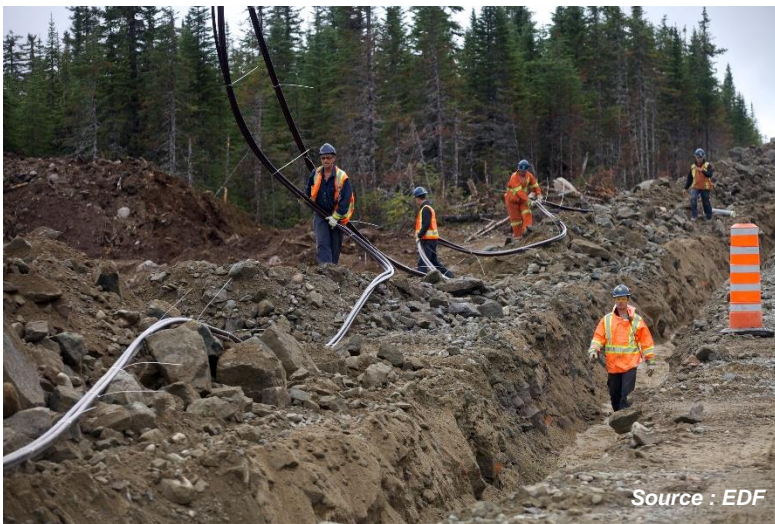
Figure 7. Installation d'un réseau collecteur souterrain
