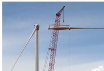
Assemblage des pales
