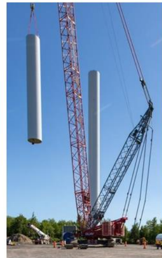
Assemblage de la tour de l'éolienne.
