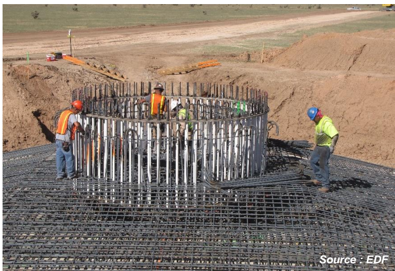
Figure 5. Construction d'une fondation d'éolienne de type gravitaire
