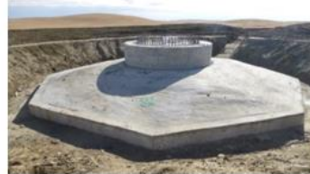
L'excavation des fondations est d'un diamètre d'environ 25 mètres. Une quantité d'environ 800 à 1300 mètres cube de béton est nécessaire pour la fondation de chaque éolienne.
