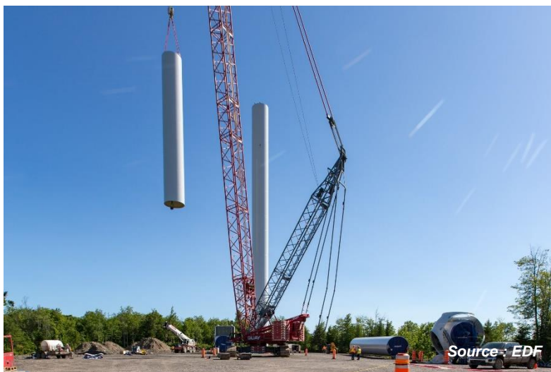
Figure 6. Assemblage d'une tour d'éolienne
