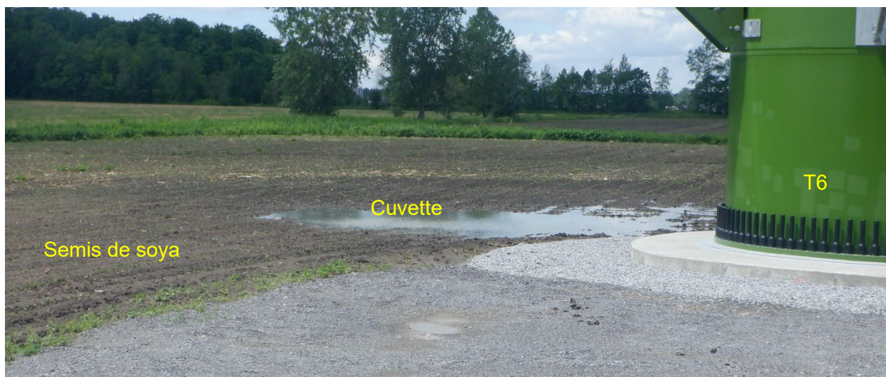
Figure 9. Éolienne T6 – Présence d'une cuvette – Parcelle JMH-2 (rec.22-05) (juin 2022)
